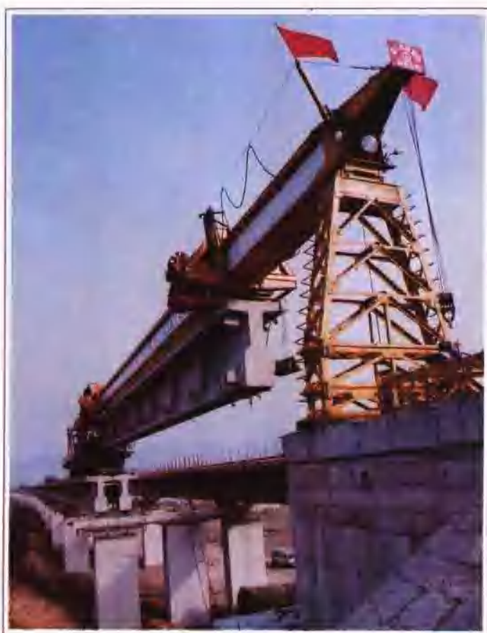
◀ 国家“八五”计划重点、大秦线亿吨配套工程——柳山线红瓦店特大桥正在架梁。
