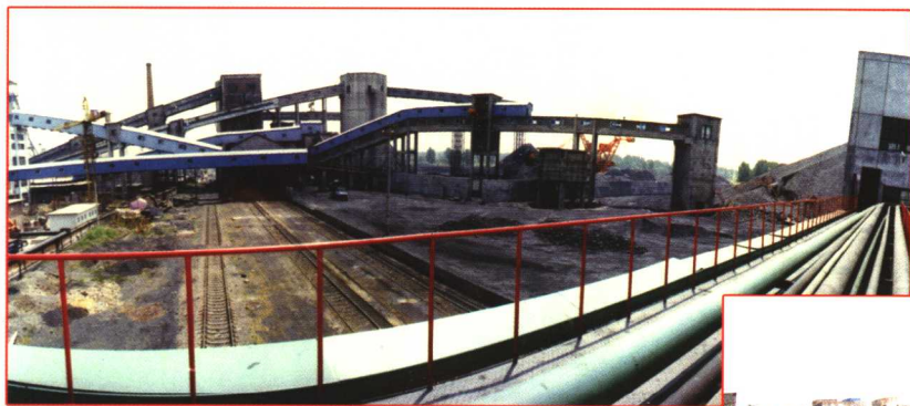
神火选煤厂储装运系统
