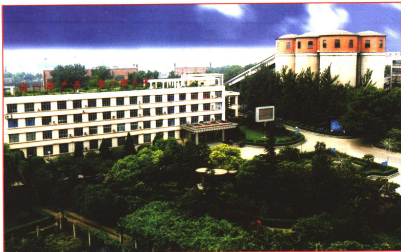
田庄选煤厂俯瞰图
