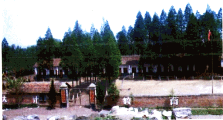
公安县闸口镇永和村村委会及小学
