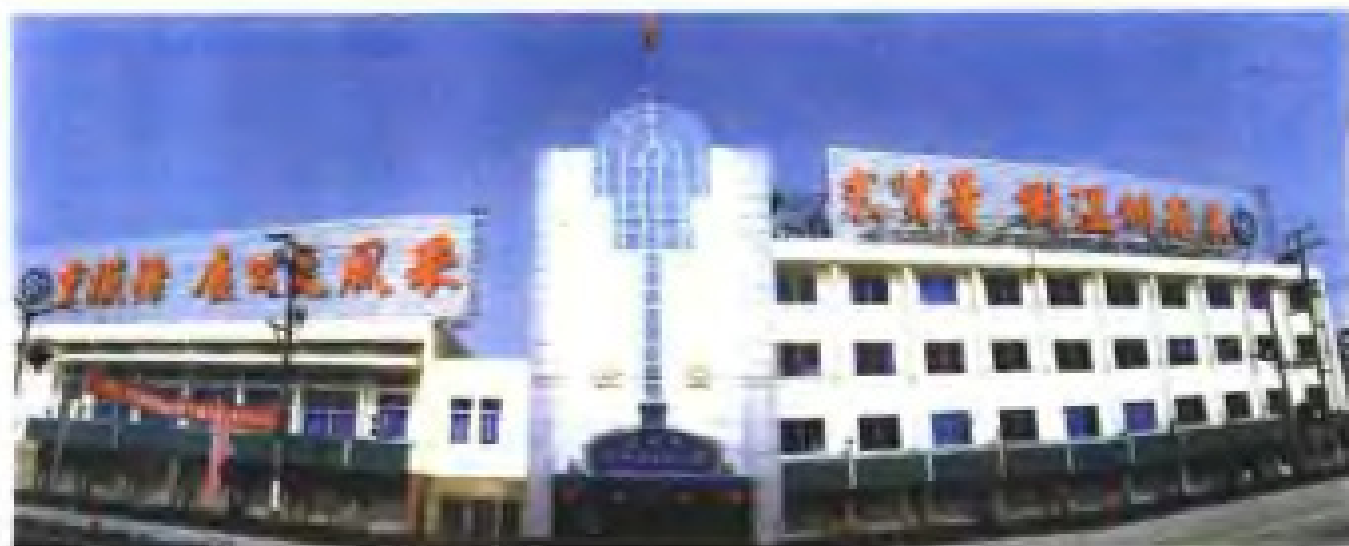
集团公司办公大楼外观
