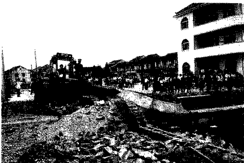
▶ 拆除非法占地建筑物现场
