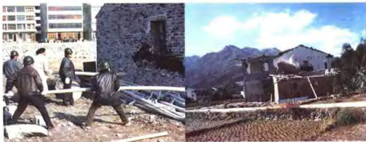
△清理拆除违章建筑
