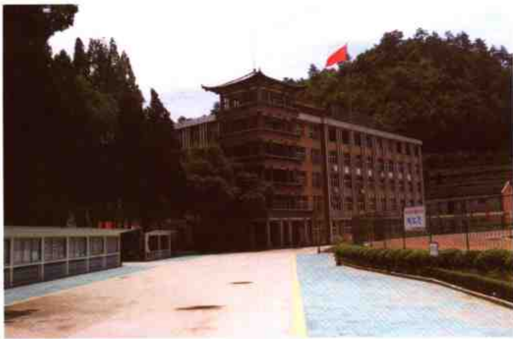
开化中学教学大楼
