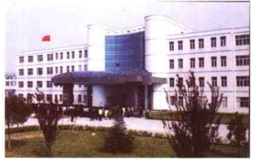
衢州市聋哑学校教学楼
