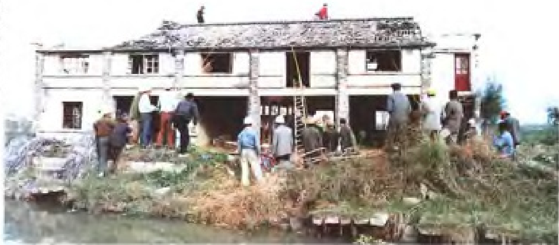
瓯海区拆房还田场景
