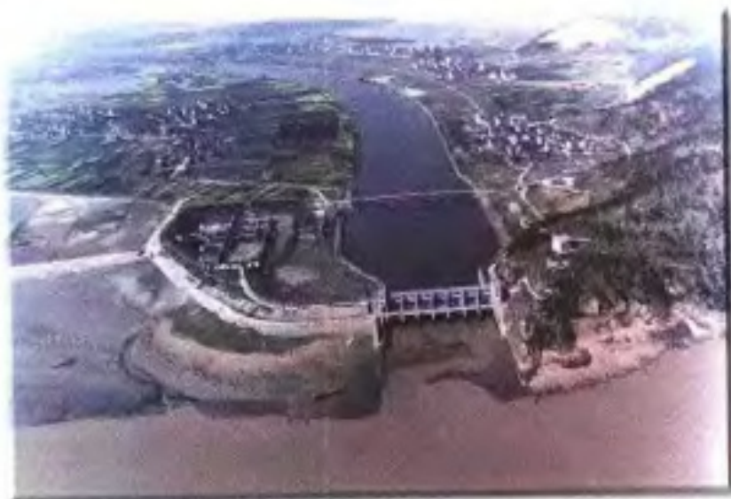
南排出海工程长山闸
