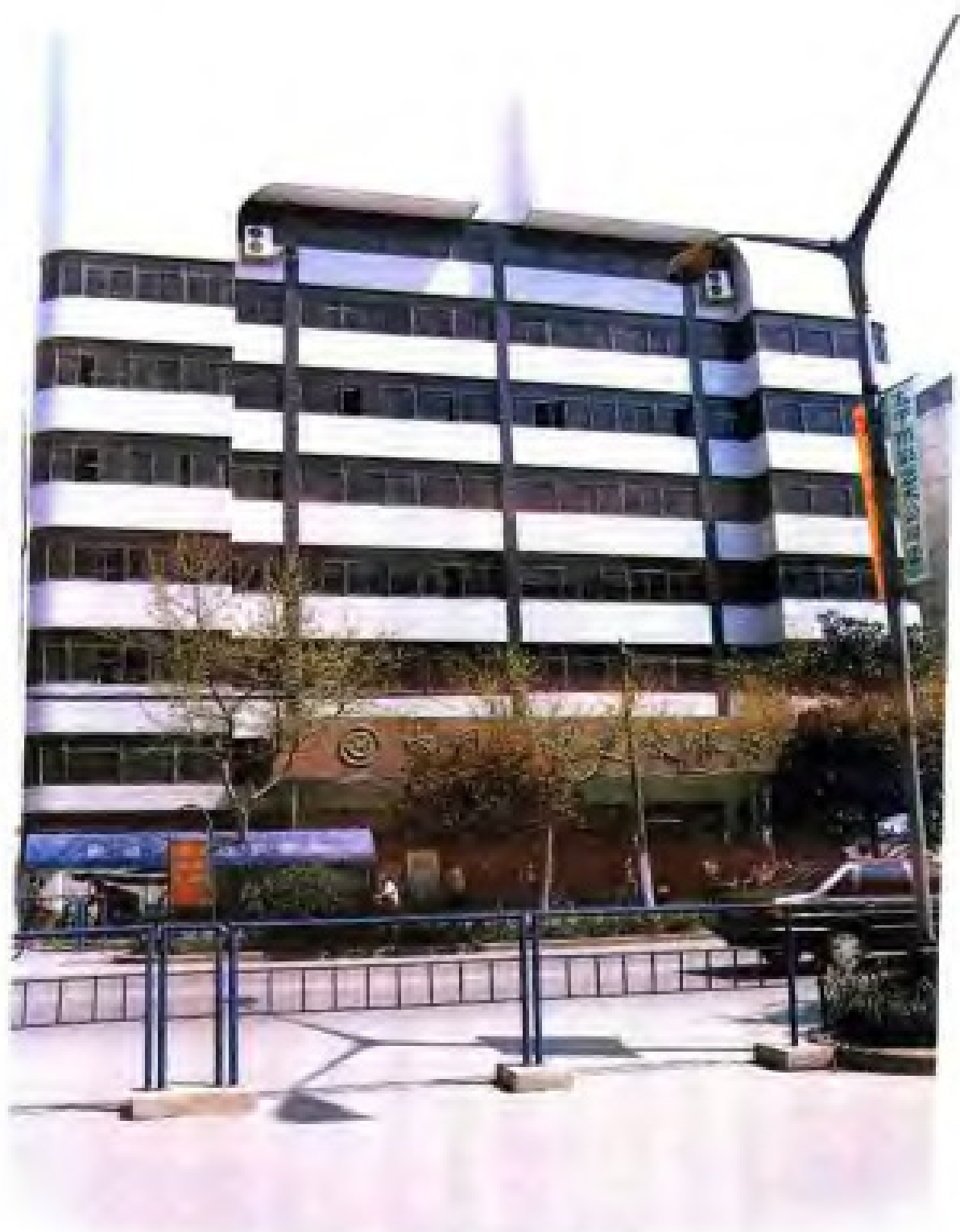
中国建设银行嘉兴市分行办公大楼外貌。
