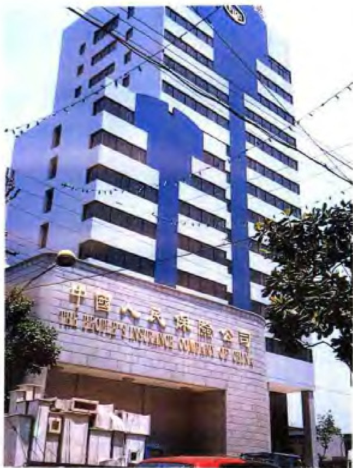
中国人民保險公司嘉兴市分公司办公大楼外觀。
