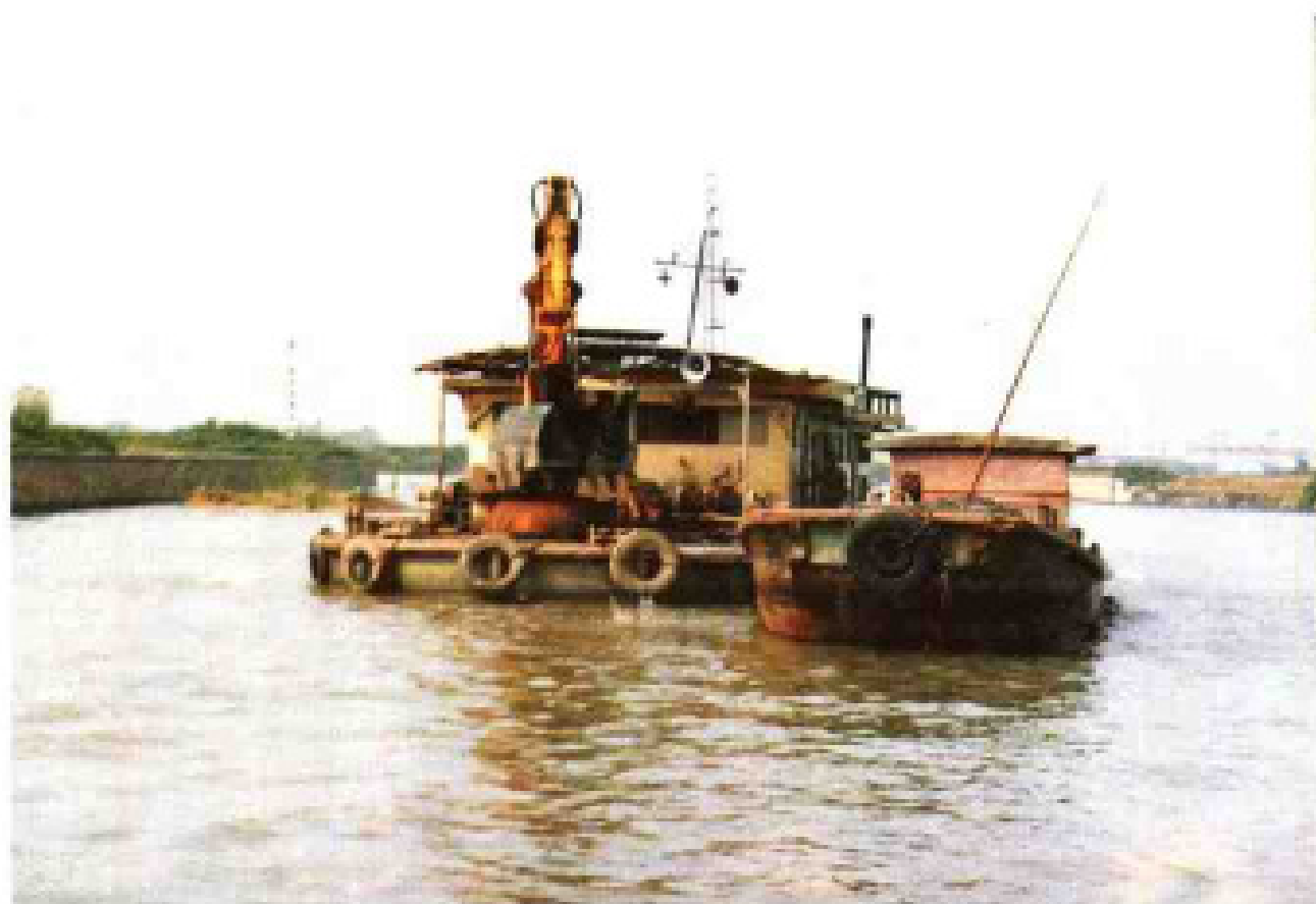
运河中线新市段在疏浚中
