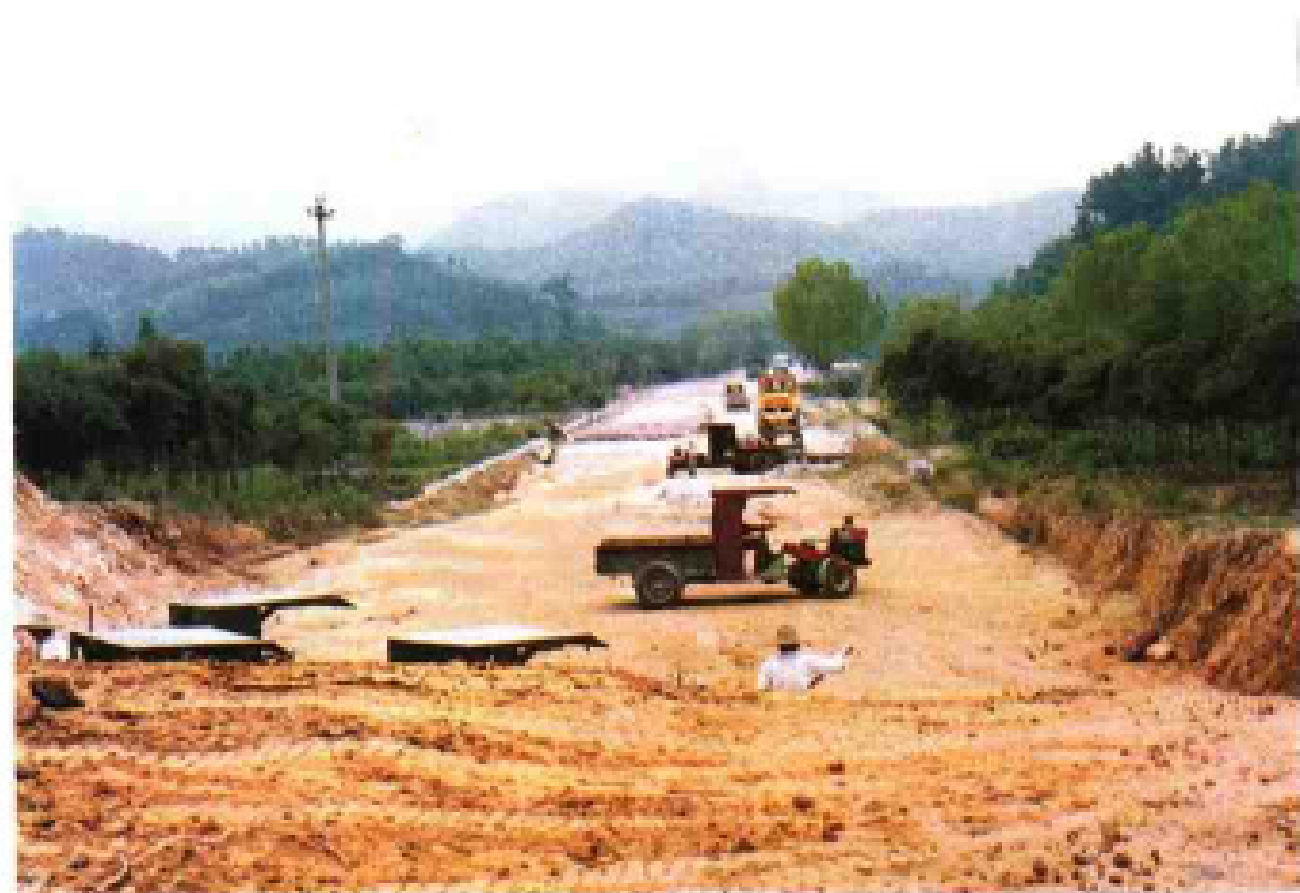
104国道水泥路面工程——上柏段施工
