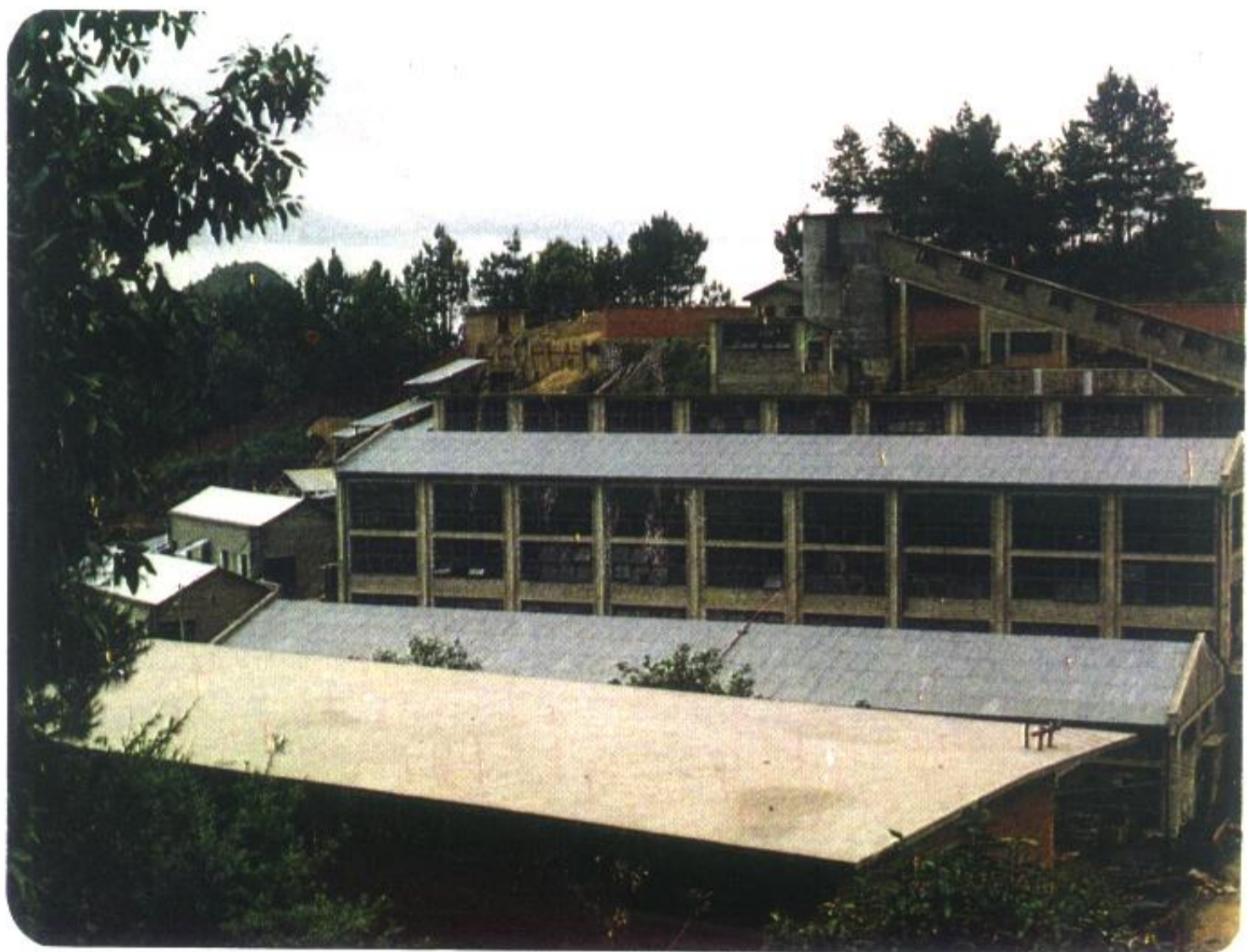
1. 云龙锡矿1985年建成日处理200吨原矿的选厂
