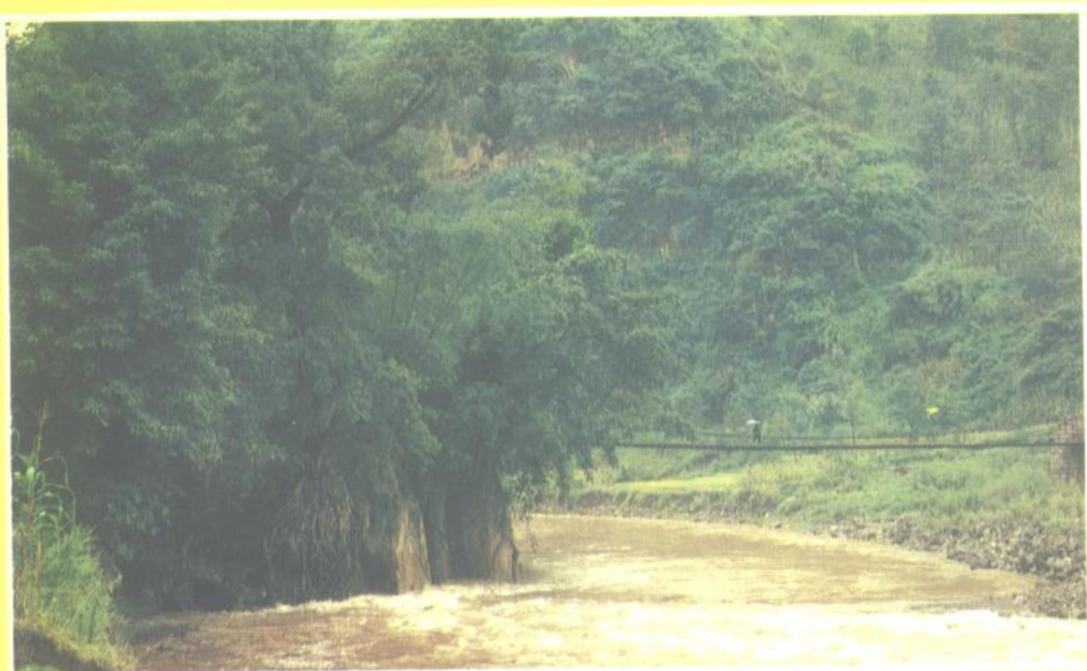
◁ 绥江县田坝乡双河铁索桥
