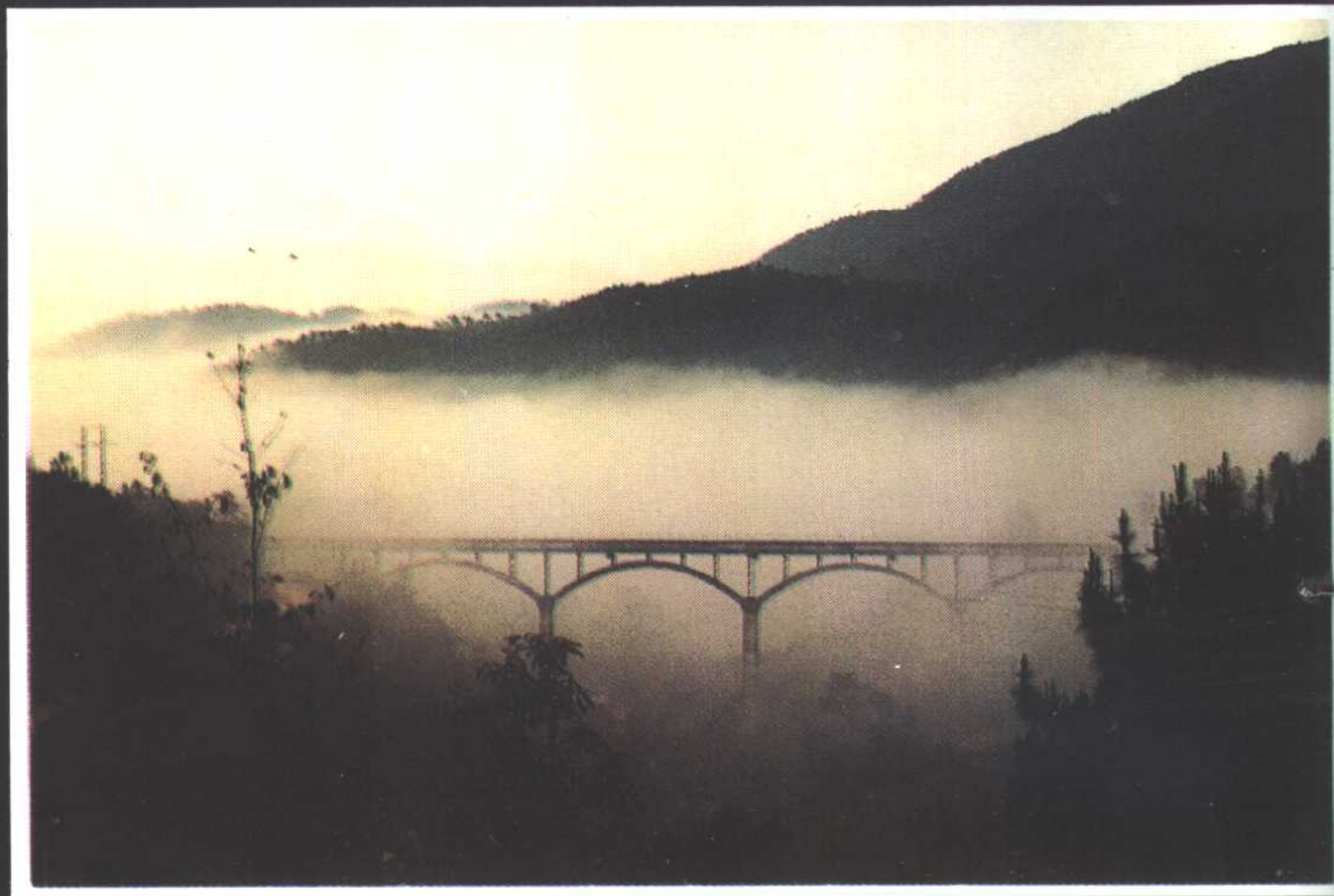
▼ 景谷河渡槽雾景
