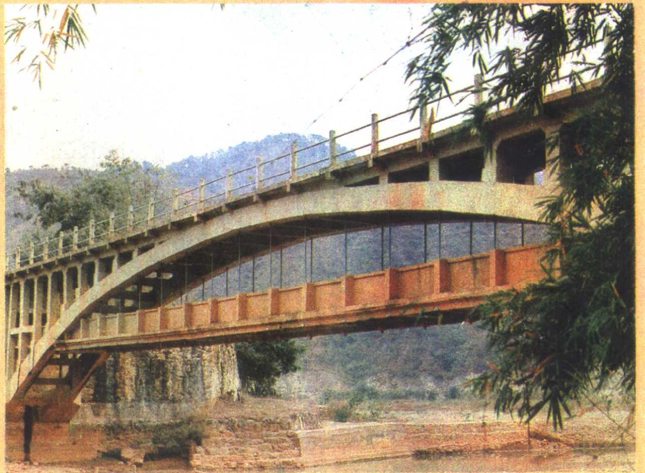
柯街“三八”沟渡槽桥
