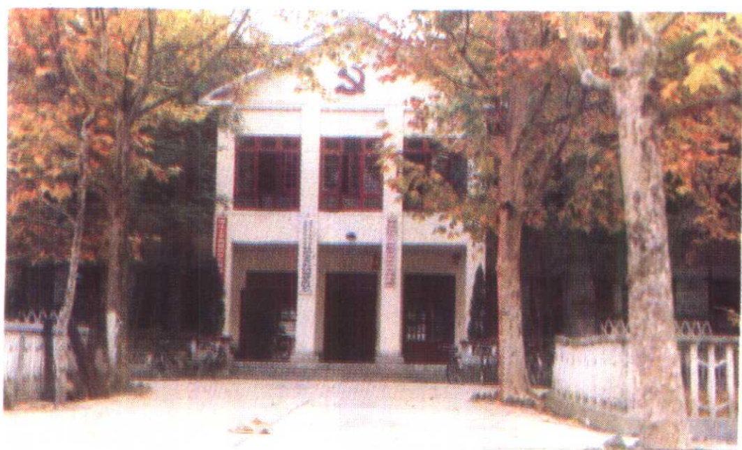
中共印江自治县委员会办公楼
