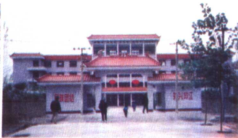
印江自治县人民政府办公楼
