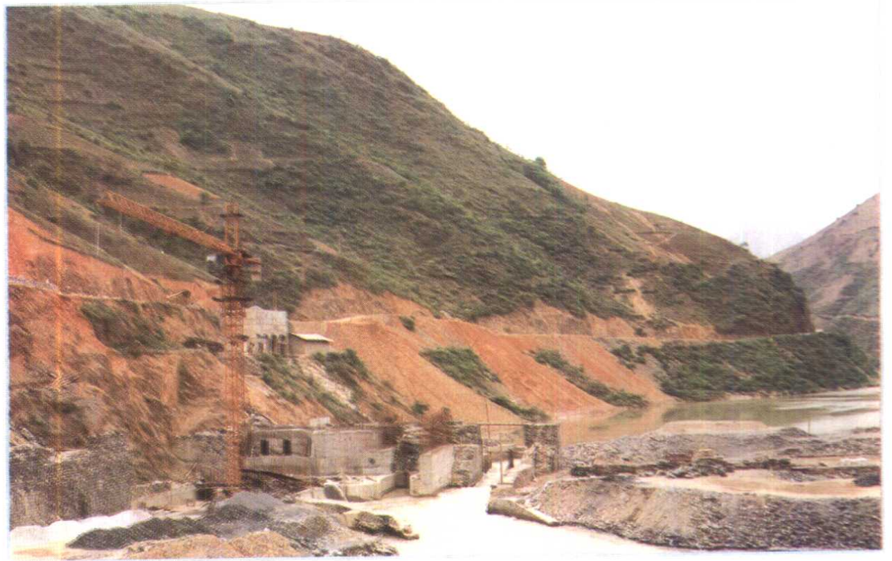
兴建中的雷公滩电站
