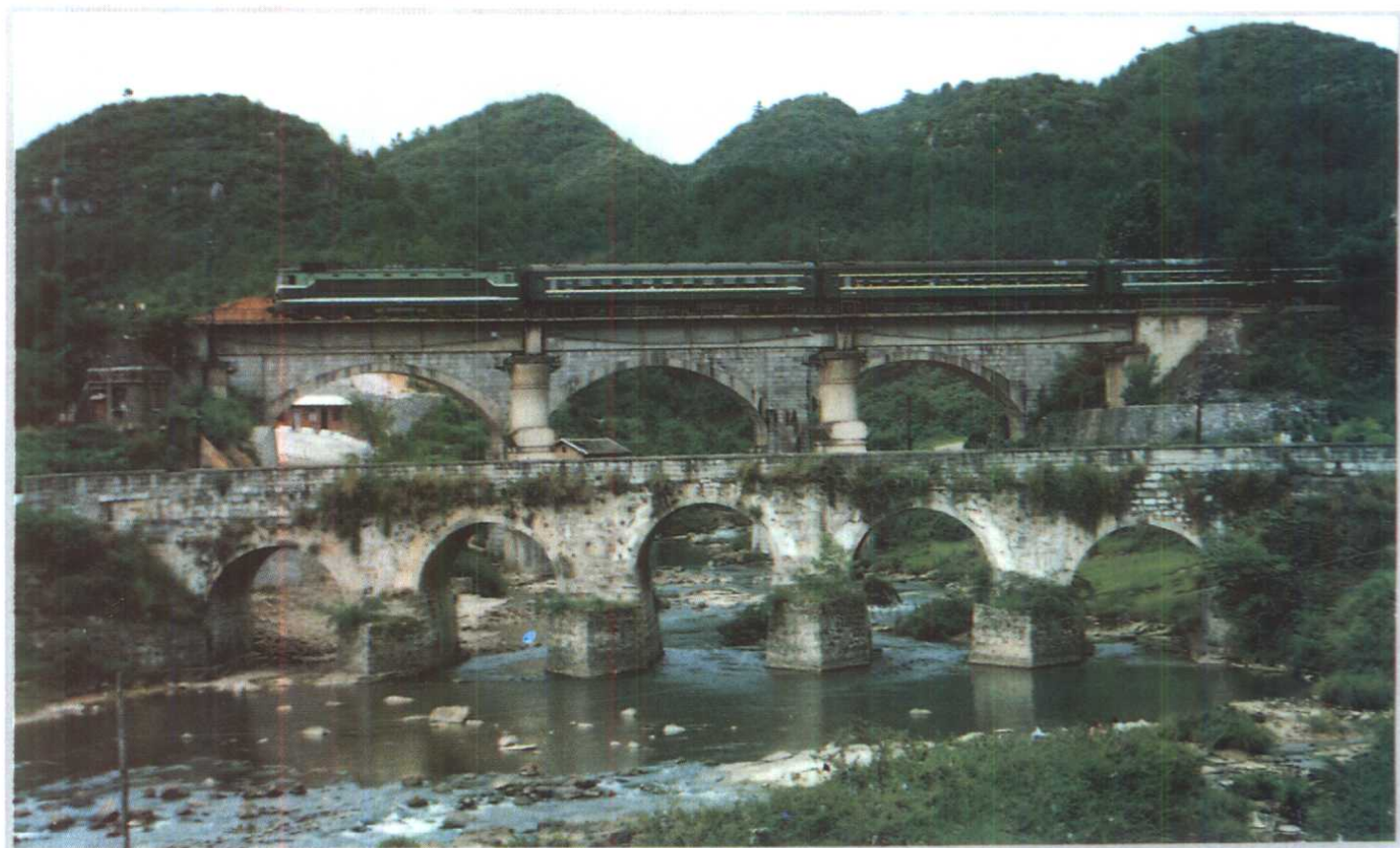
横跨打草河上的铁路、公路桥
