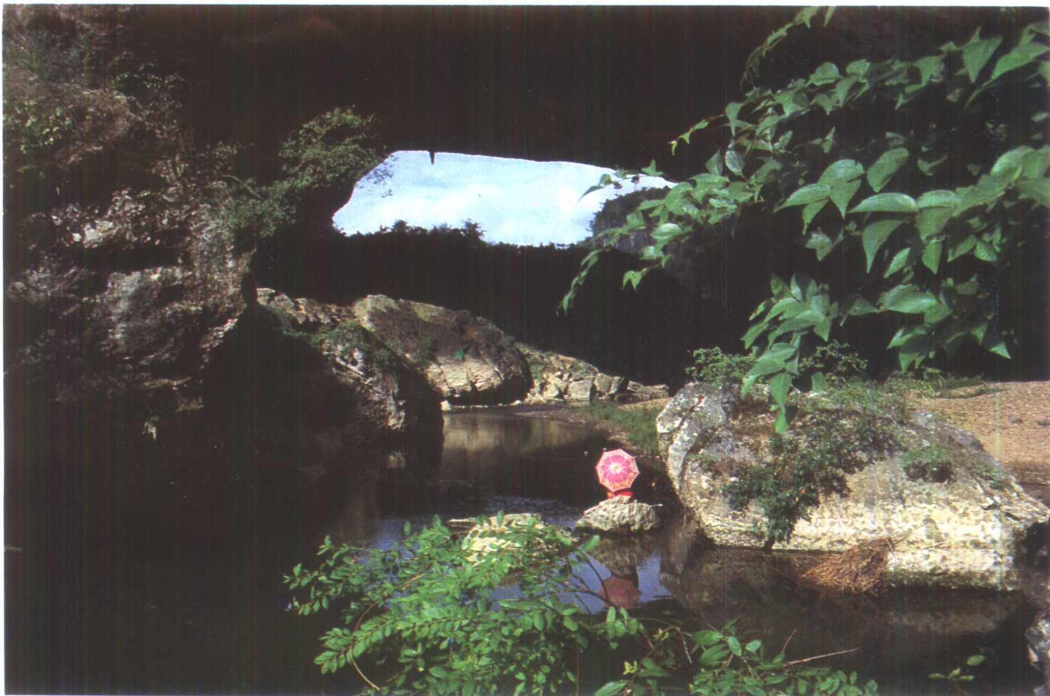
高屯天然石拱桥（桥跨度 119 米，宽（顺河）138 米高 39 米
