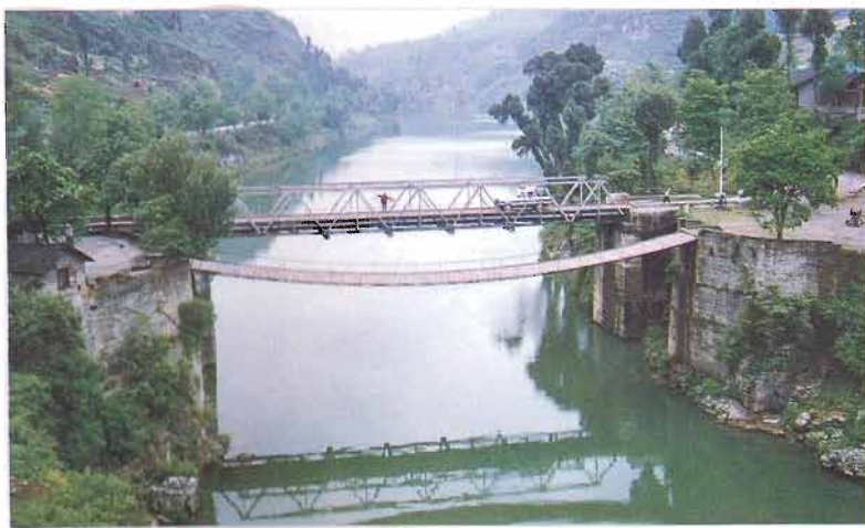
重安古铁索桥 田绍林 摄
