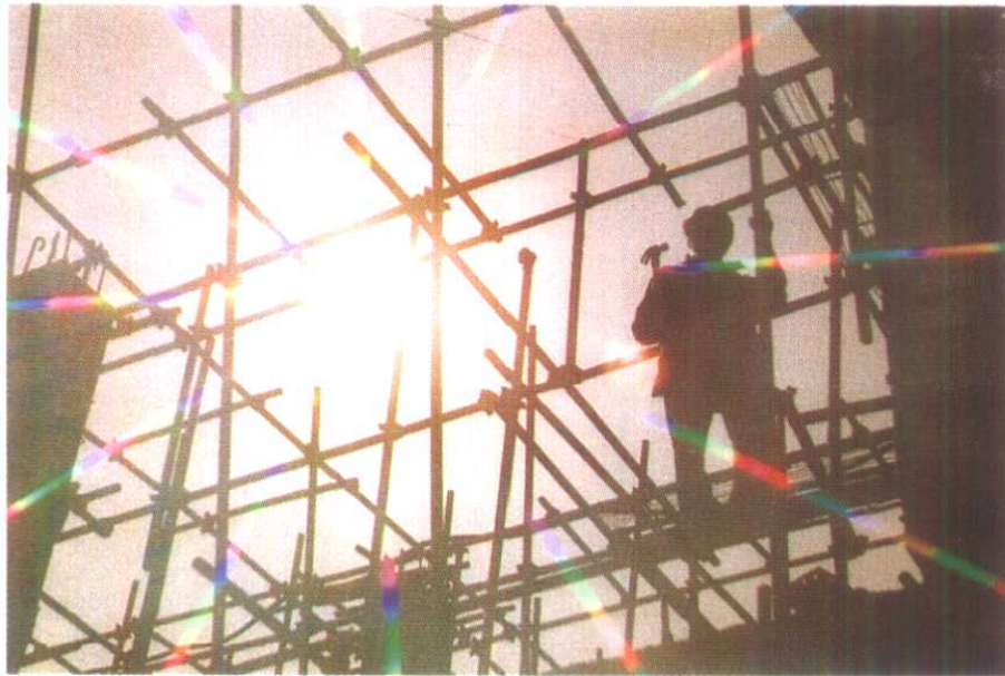
福泉重钙厂在建设中
