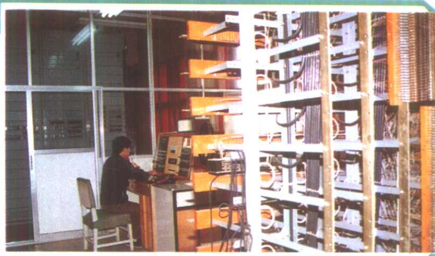
邮电大楼及承控电话室
