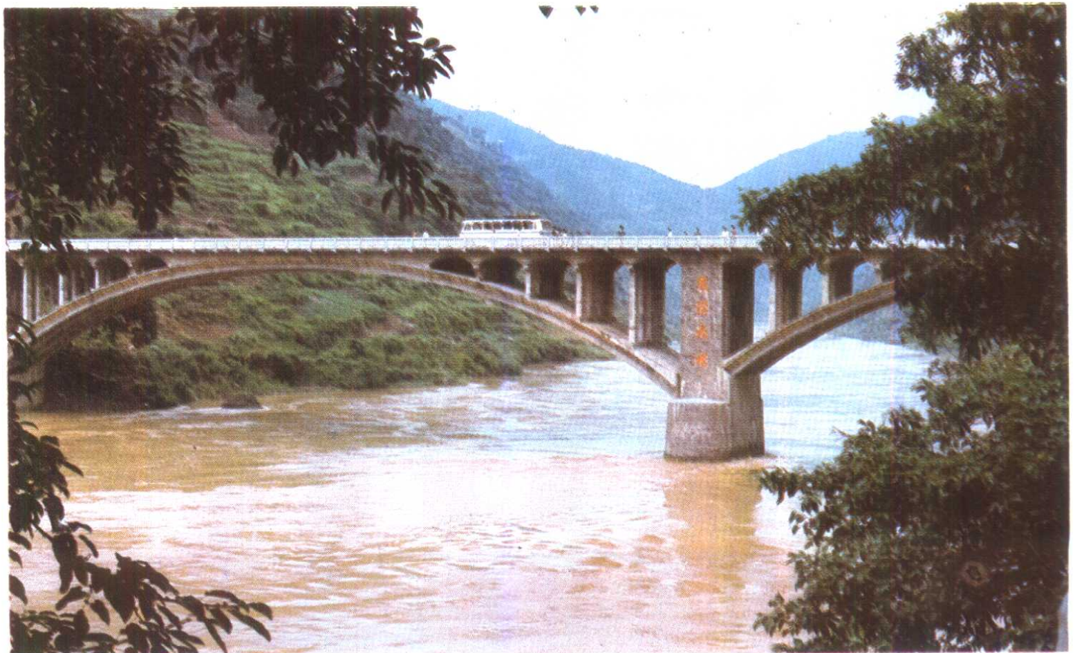
赤水河上的风溪大桥
