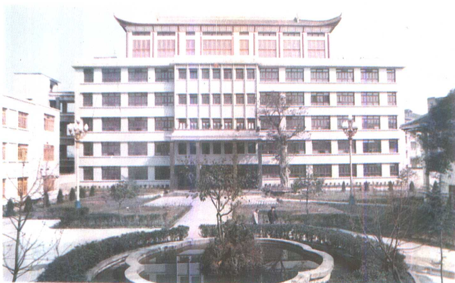
赤水县人民政府机关办公楼
