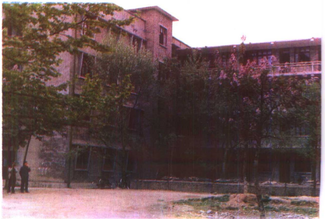
岑巩县人民政府办公楼
