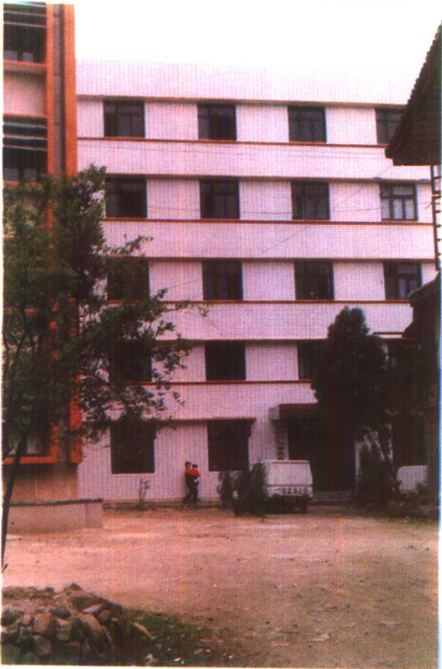
岑巩县政协办公楼
