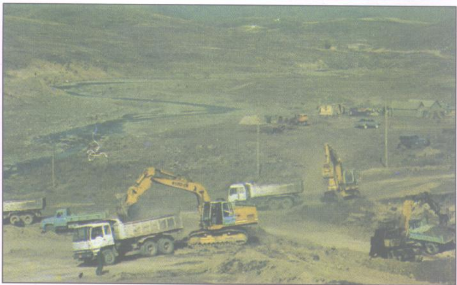
建设中的大型 水利工程——喀浪 古尔水库
