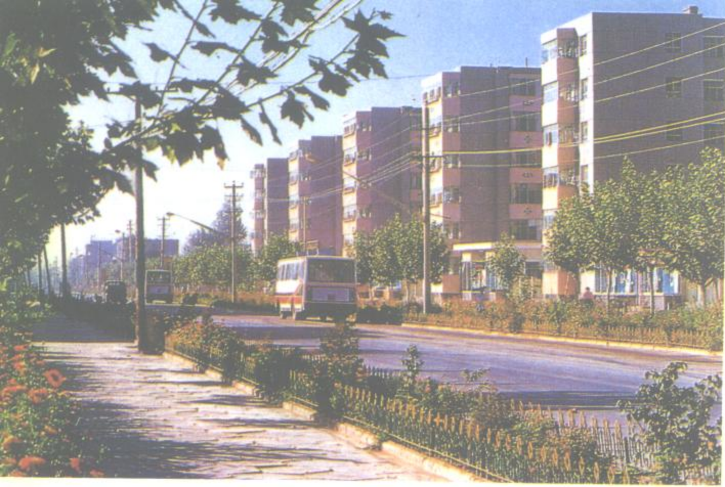
新建住宅楼群
