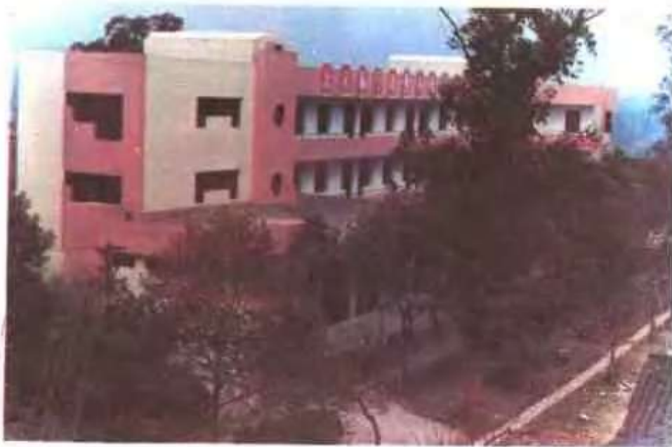
富顺县第二中学校初中教学楼
