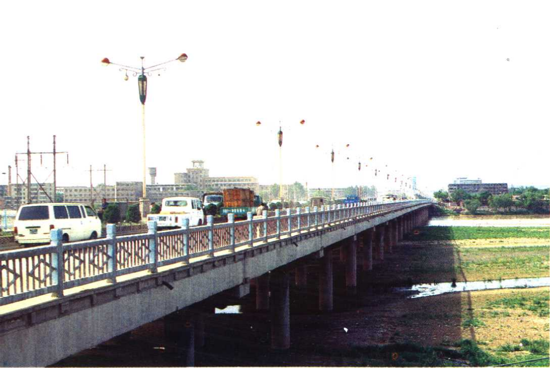
渭河公路大桥
