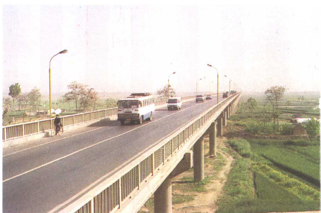
渭南沙王渭河公路大桥
