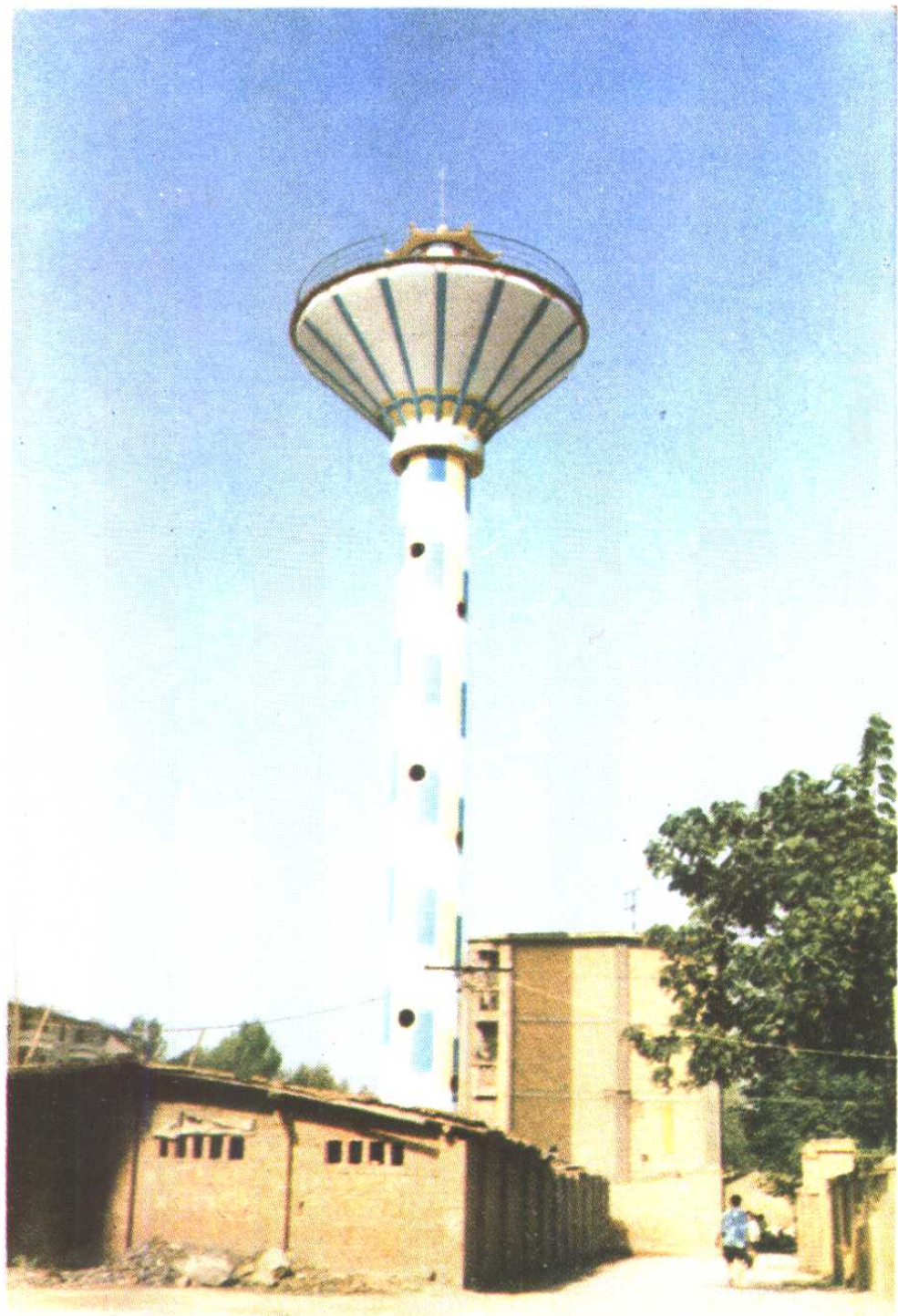
渭南铁路桥梁处的倒锥壳水塔
