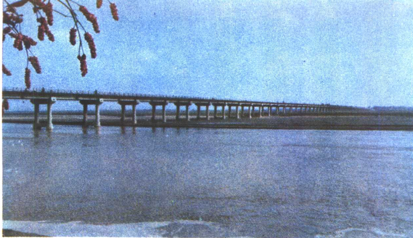
西北最长的公路大桥 ——渭南渭河大桥
