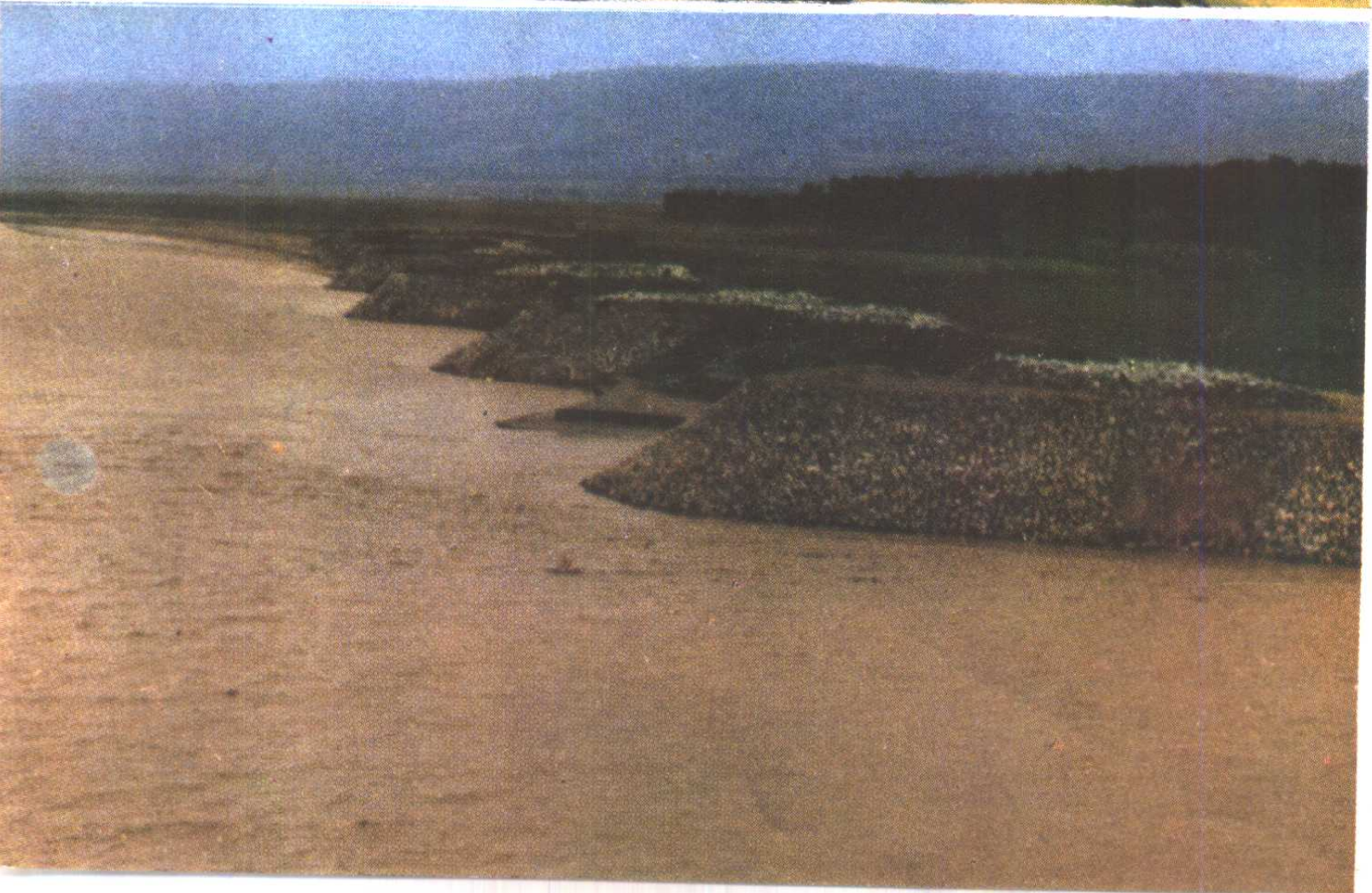
渭河南岸的丁字坝
