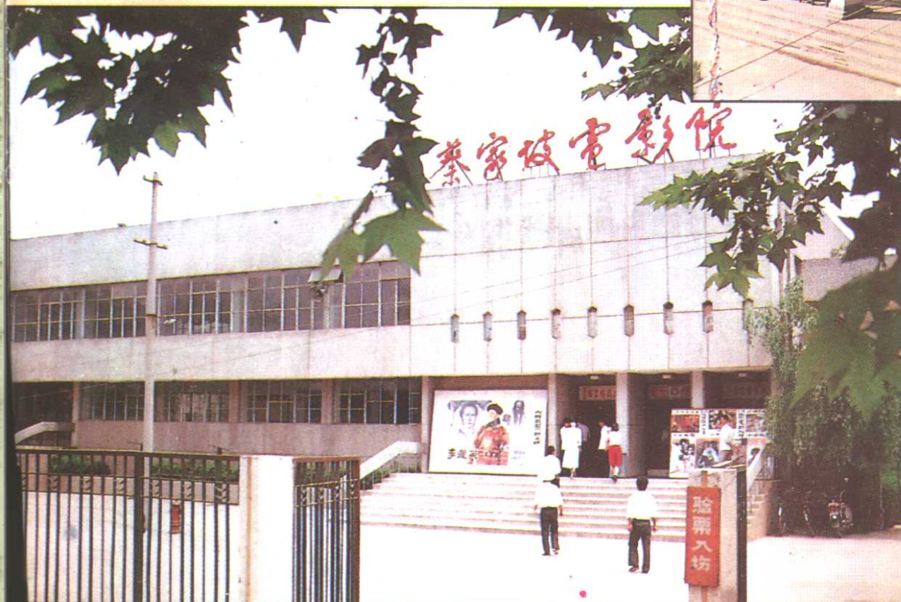
蔡家坡电影院
