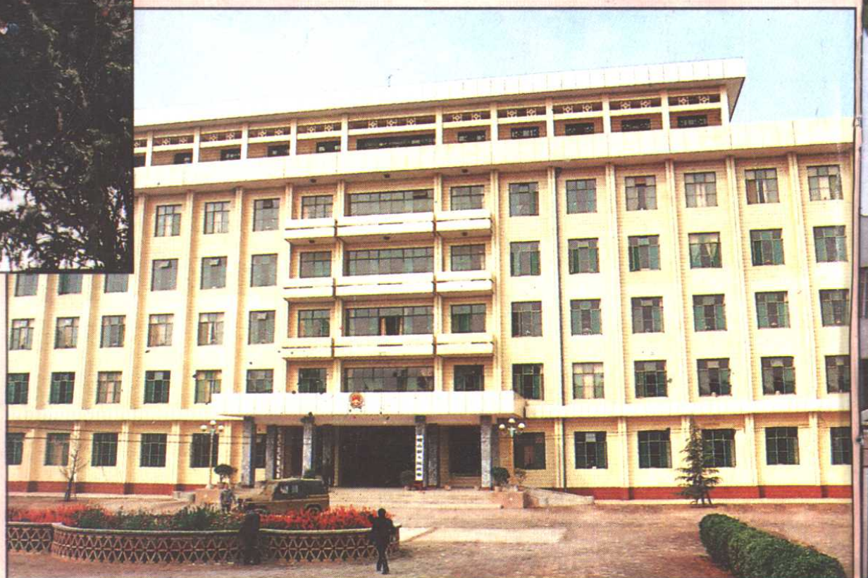
县人民政府办公楼
