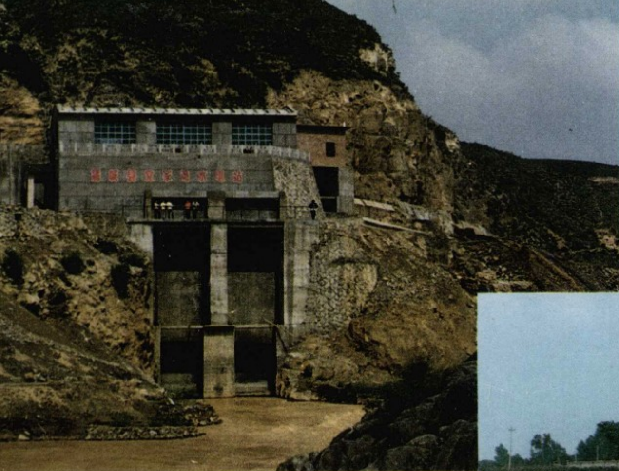
党家湾水电站
