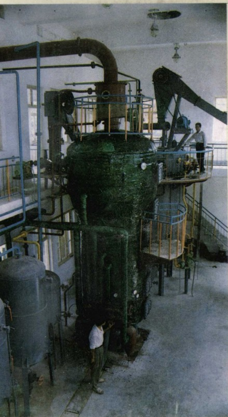
荆姚镇荆西油脂厂生产车间
