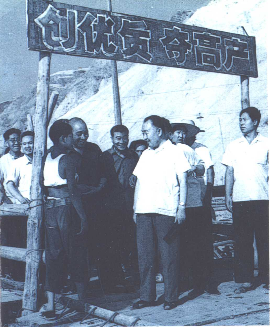
◀ 中共陕西省委书记马文瑞(右三)1979年7月27日视察东雷抽黄工程新民二级站工地
