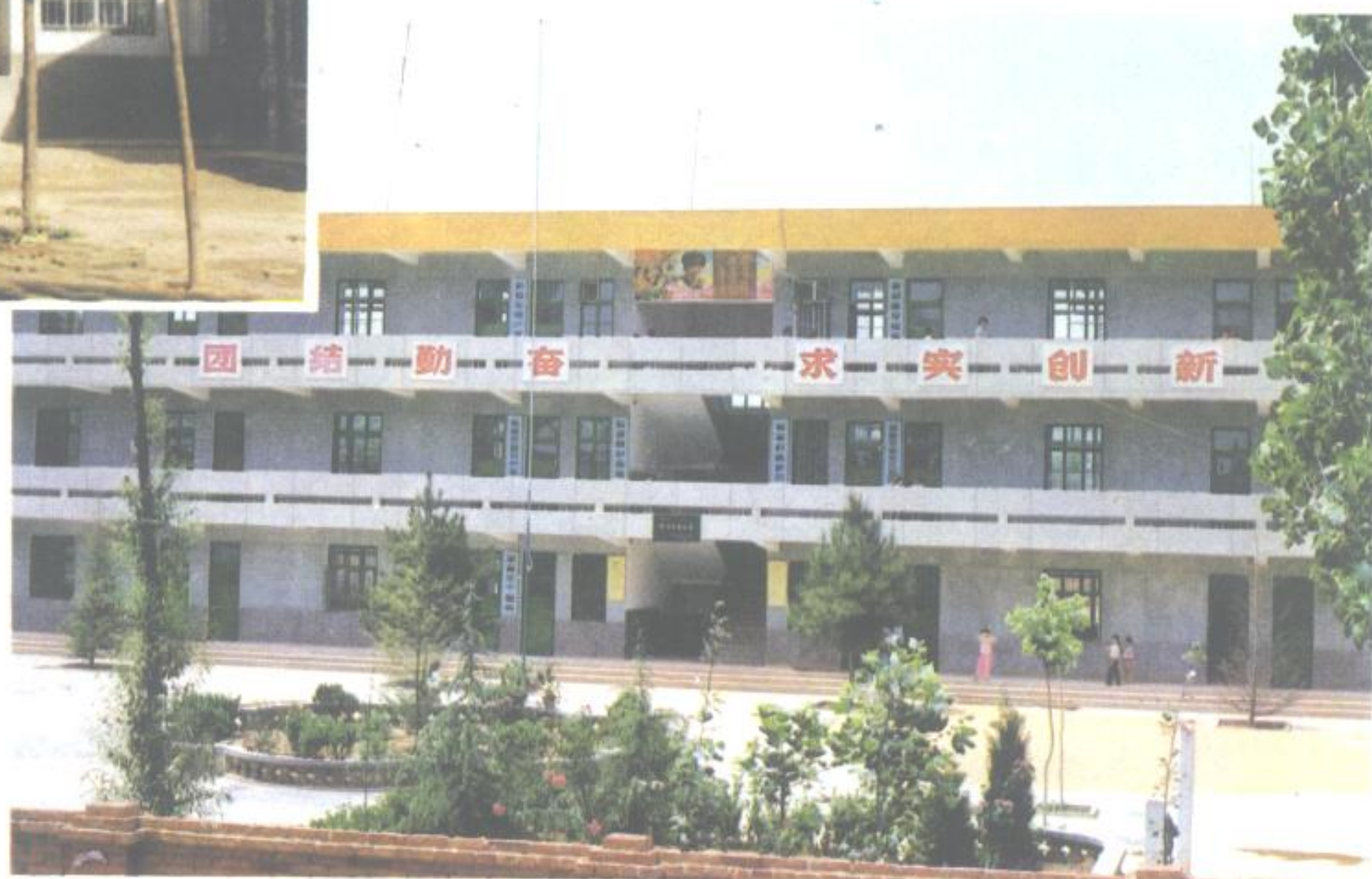
农村示范小学：孙家南 头小学教学楼
