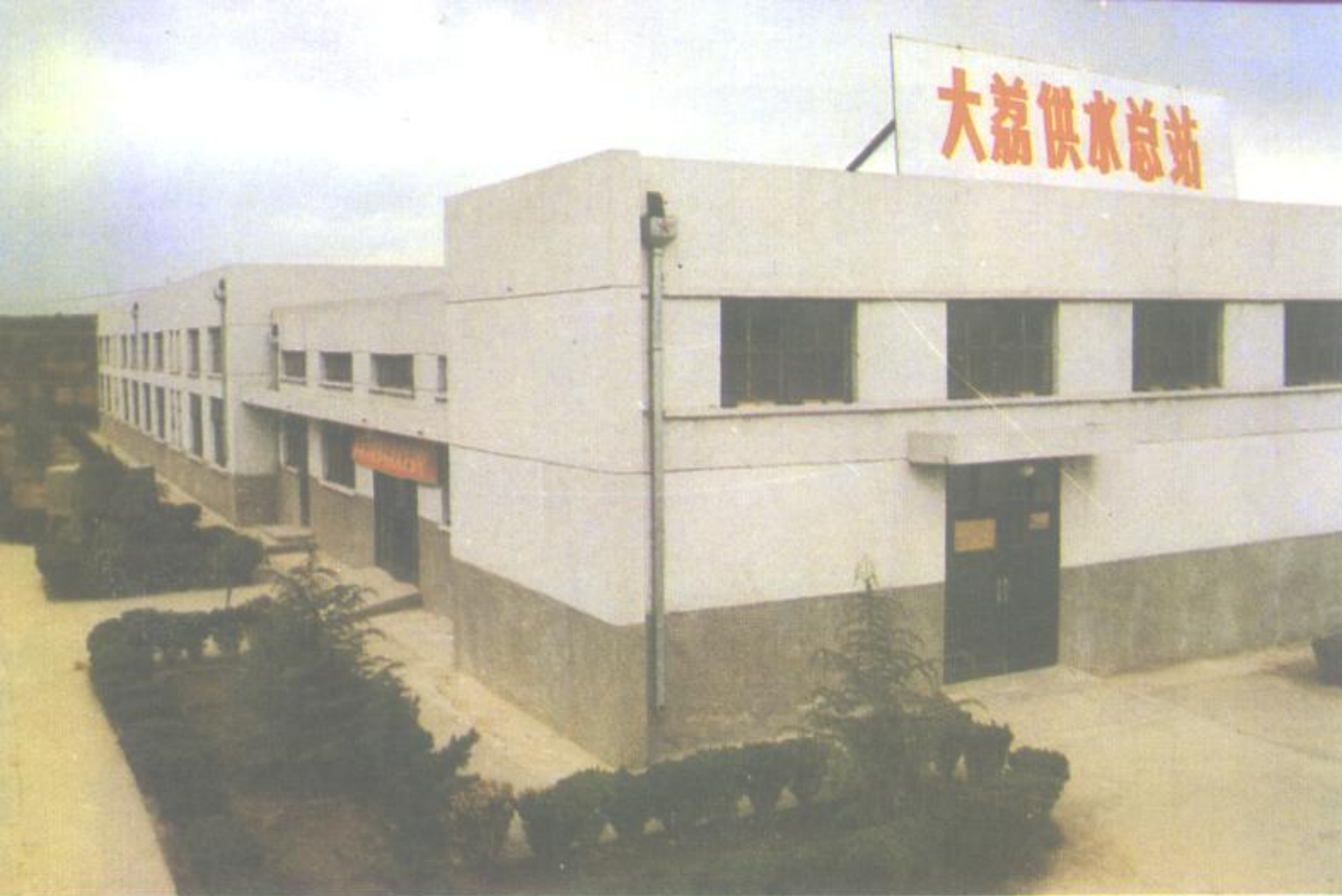
大荔供水总站
