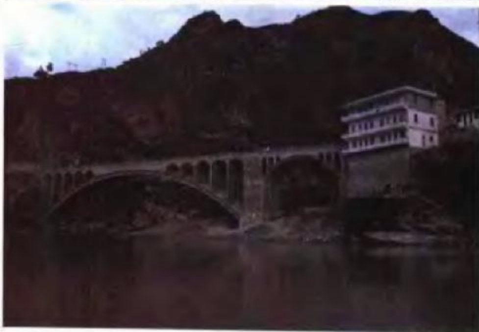
旬(阳)白(河)公路冷水河大桥
