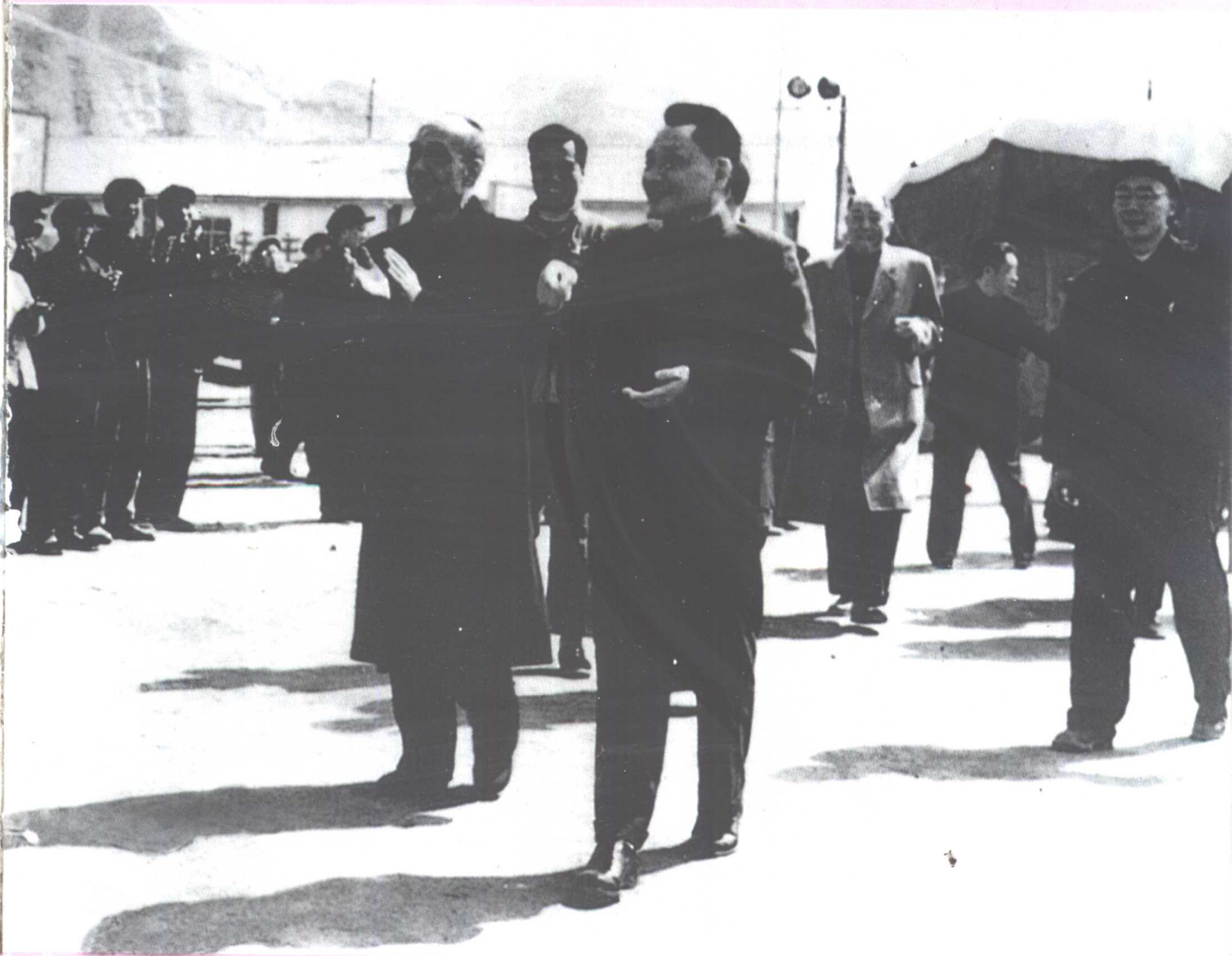
1964年国务院副总理邓小平、李富春视察刘家峡水电站建设工地
