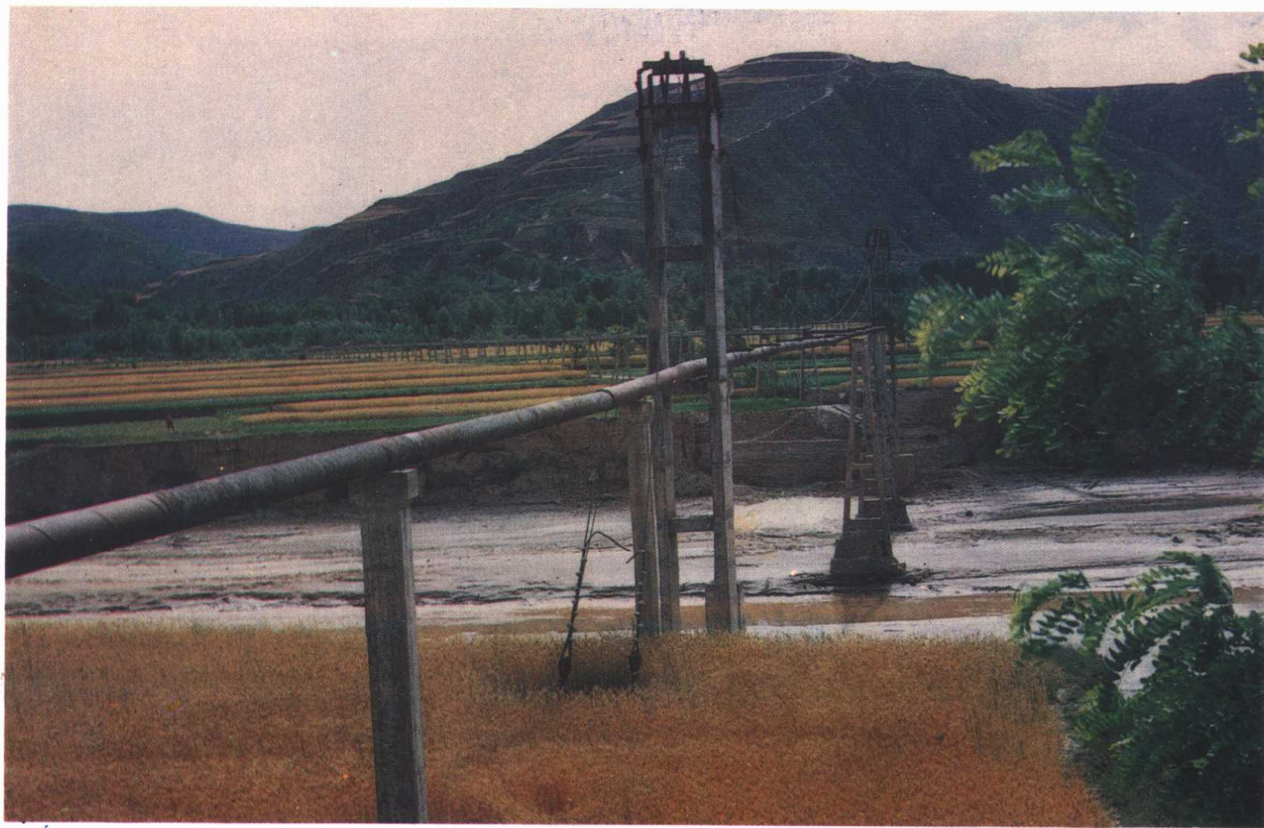
曲子刘旗跨江渡槽
