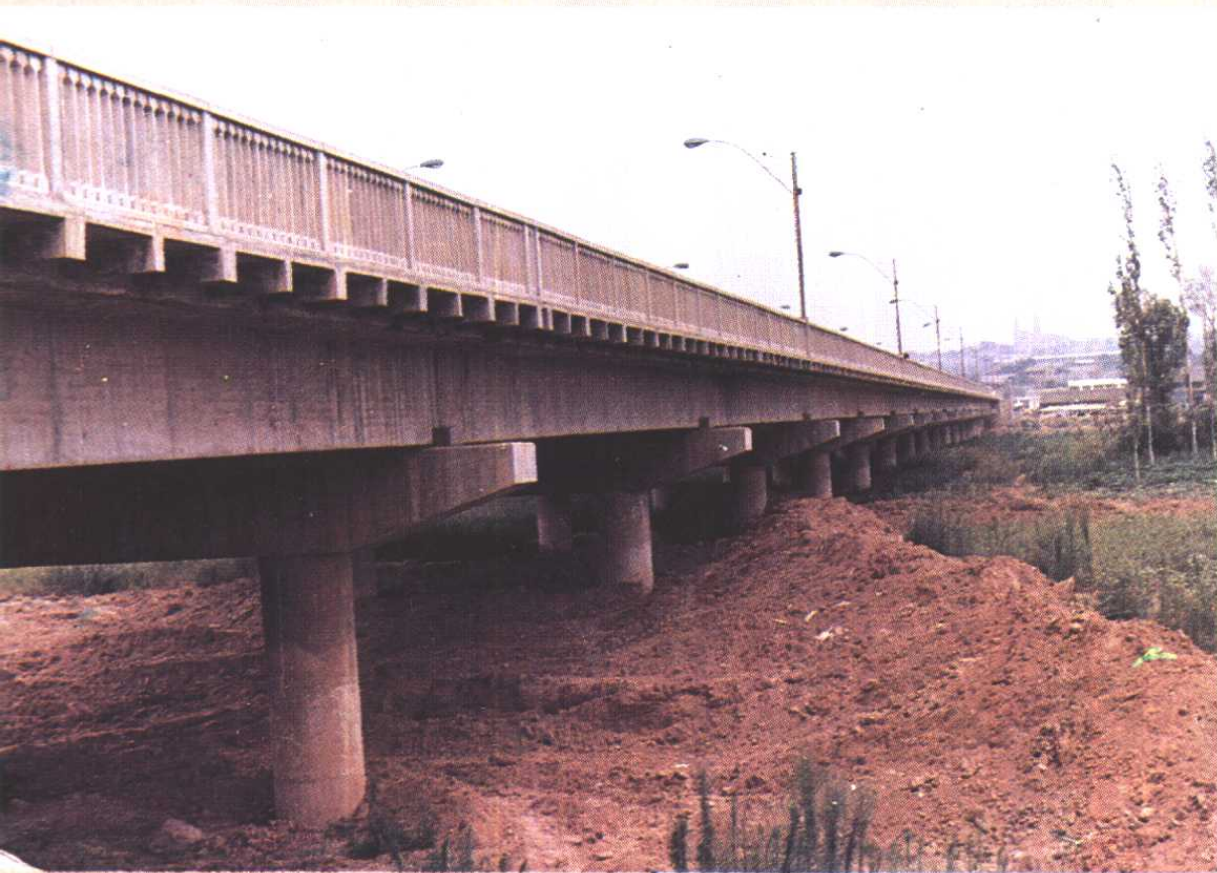
新絳汾河大橋
