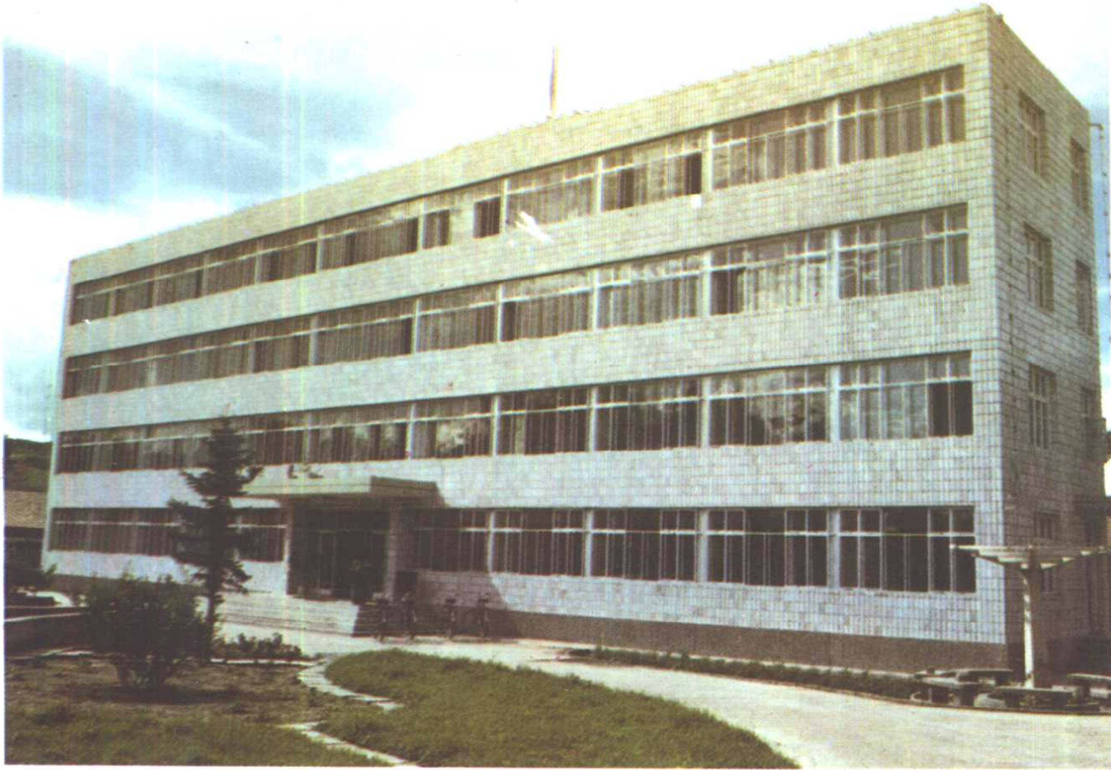
中共克什克腾旗 委员会办公楼
