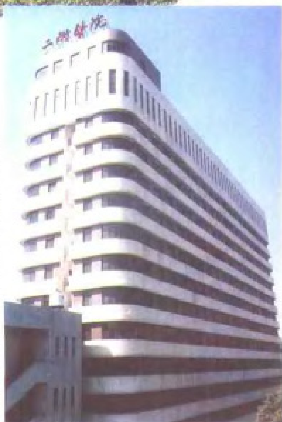
江西医学院第二附属医院外科病房大楼。
