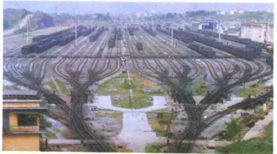
鹰潭站编组场三级三场 1990年12月竣工 (余成松 摄)
