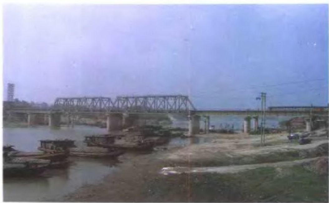
△向九线山下渡大桥 1990 年 完成架梁 (南昌铁路分局供稿)
