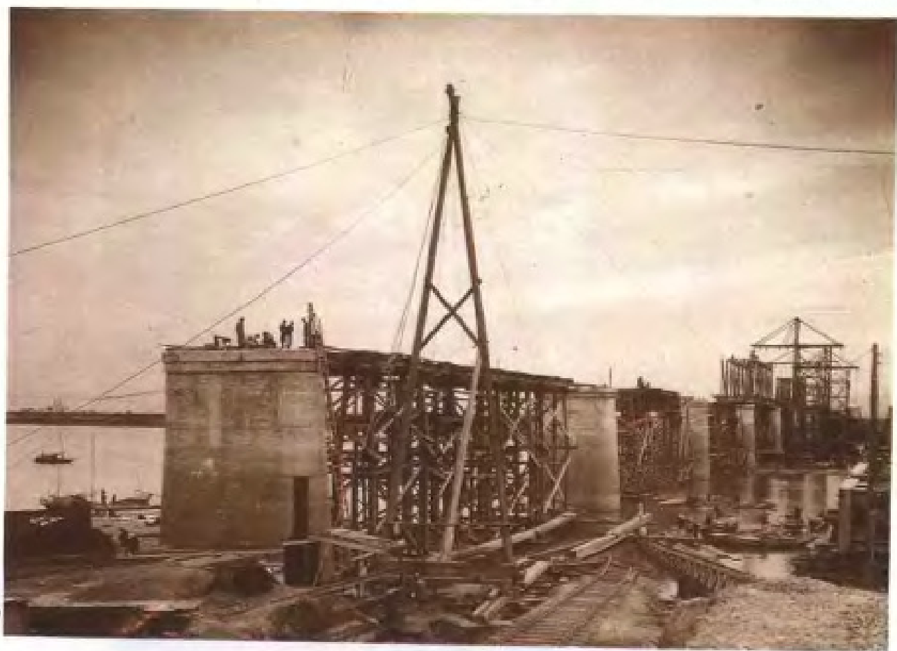
浙贛綫樟樹 贛江大橋， 1948年12月 修復通車 (李新華供稿)
