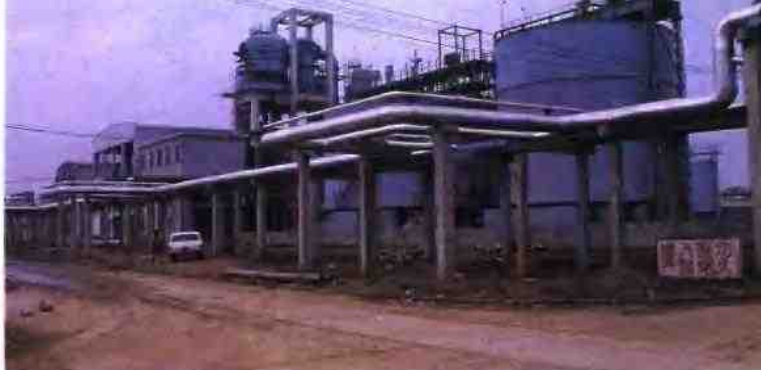
贵溪化肥厂引进的磷酸生产装置
