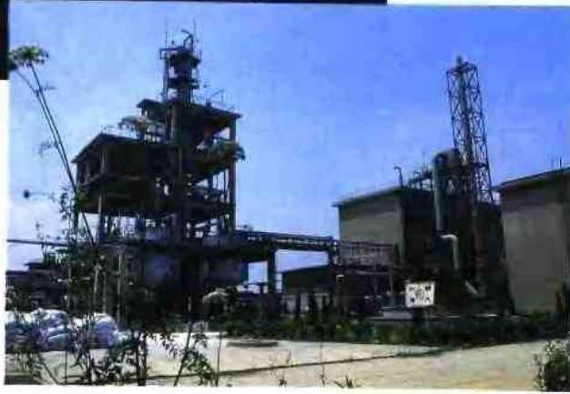
九江化工厂 2 万吨聚氯乙烯车间
