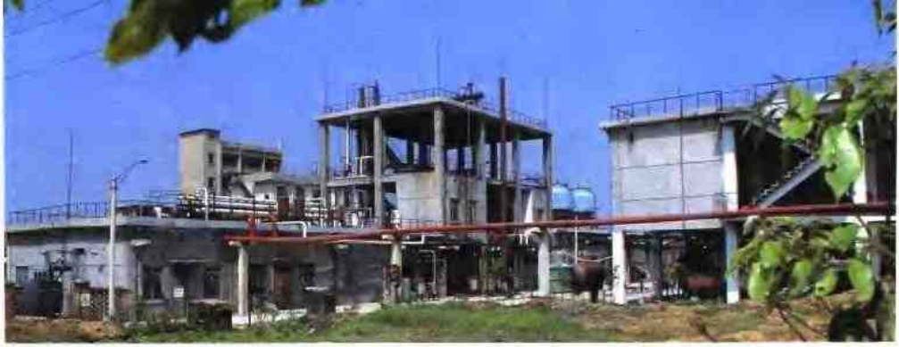
南昌农药厂 嘧啶氧磷工地
