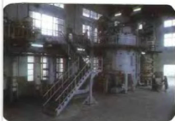
樟樹糧油公司浸出油車間
