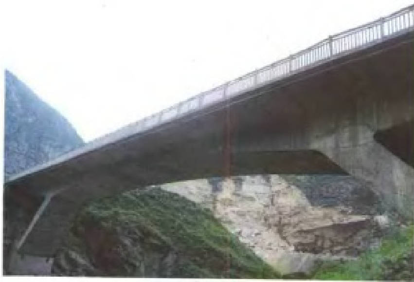
◀ 105 国道遂川县境内的预应力混凝土斜腿刚构桥——洪门大桥
