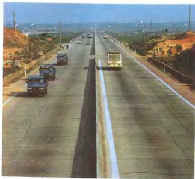
▶ 穿越江西的 105 公路国道线北段—— 南昌——高坊岭一级公路 (周武刚摄)
