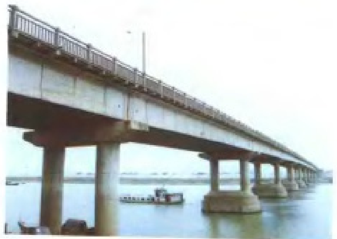
▲ 横跨昌江下游的预应力混凝土T型梁桥——浚阳姚公渡大桥
