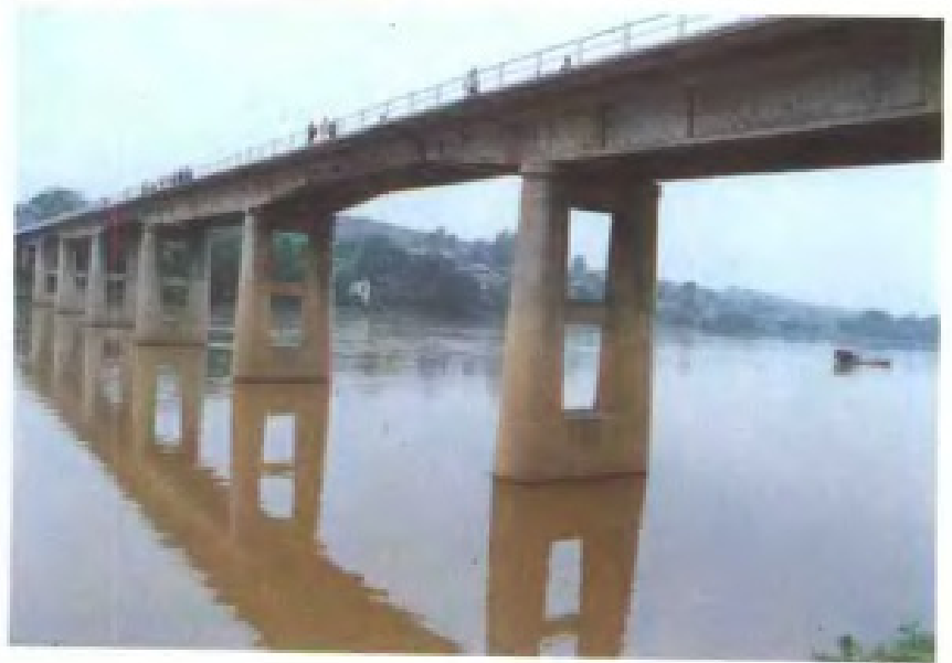
▶ 横跨赣江的钢箱混凝土悬臂梁桥——赣州西河大桥
