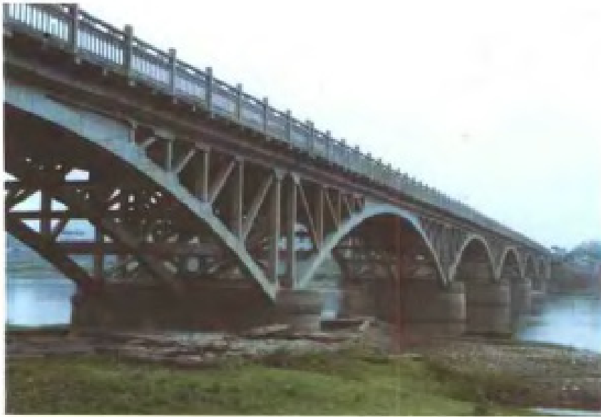
◀ 位处上饶市区的钢筋混 凝土桁架拱的前进大桥
