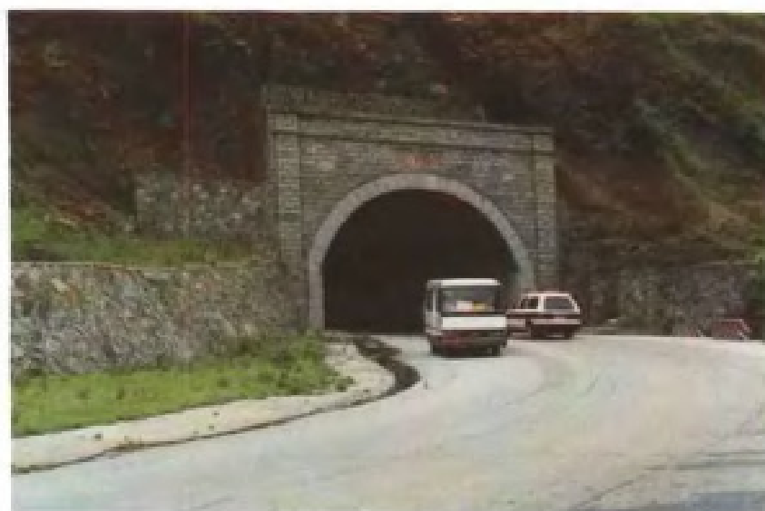
▶ *105国道遂川洪门地段的隧道——拱门隧道
