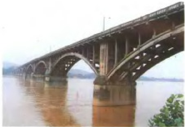
▶ 位于赣州市区东部横跨贡江的大跨径 钢筋混凝土肋拱桥——赣州东河大桥
