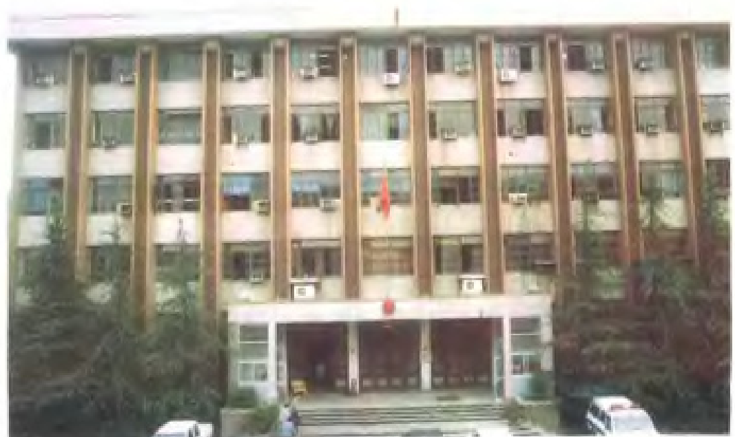
南昌市中级人民法院办公楼
