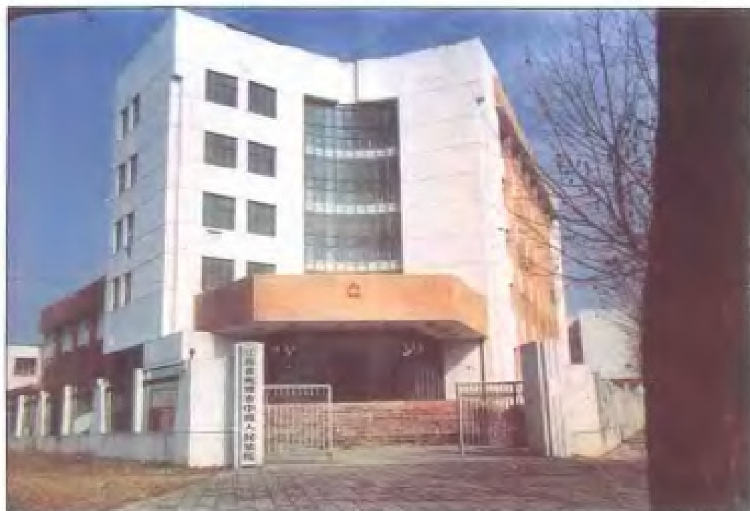
鹰潭市中级人民法院审判、办公综合大楼
