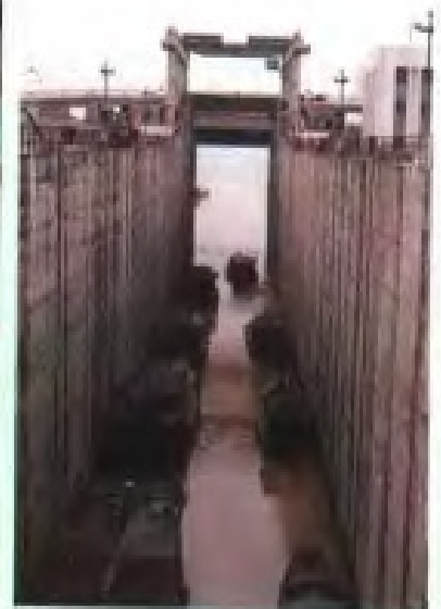
万安水电站船闸
