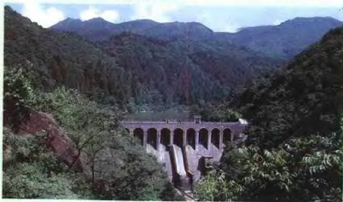
庐山水电站大坝 (孟宪伟、蓝天摄)
