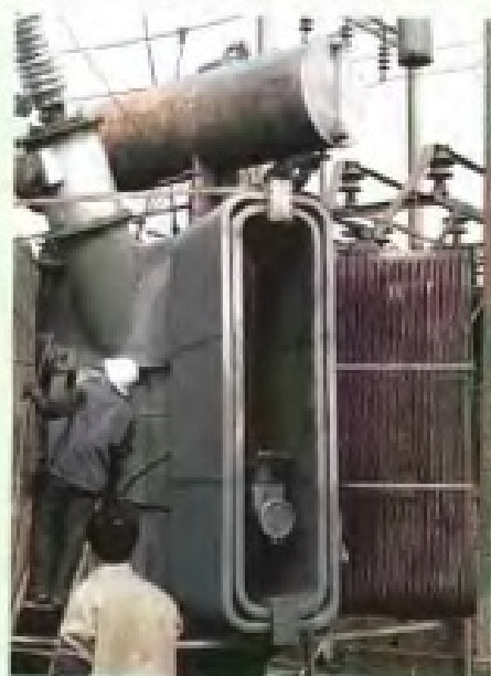
新余火力发电厂的工人正在检修变压器
