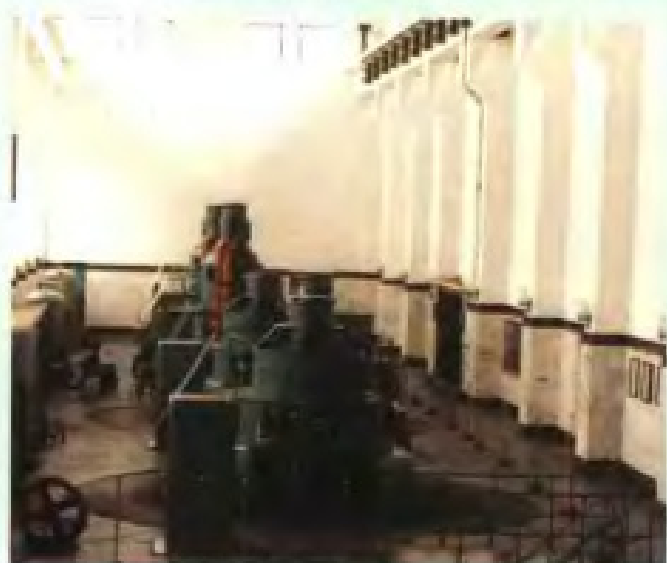
江口水电站, 1964 年 9 月第一台机组投产, 现装机 3.52 万千瓦 (郝伯康摄)
