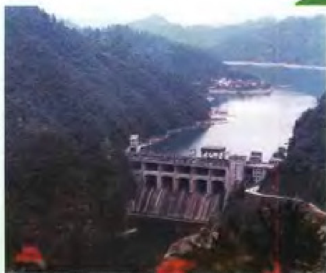
上犹江水电站, 4×1.5万千瓦机组, 第一台机组 1957 年 12 月投产发电 (王诚志摄)
