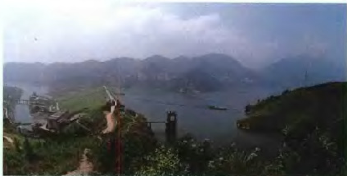
柘林水电站大坝全景, 装机 4×4.5 万千瓦, 第一台机组 1972 年 8 月投产发电 (王仲荣摄)
