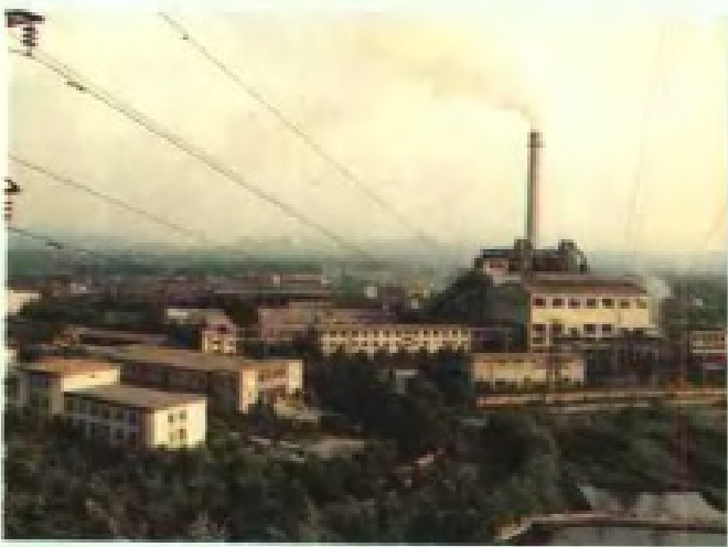
景德镇发电厂, 现装机容量 2 \times 5 万千瓦, 1976 年 6 月 第一台机组投产
