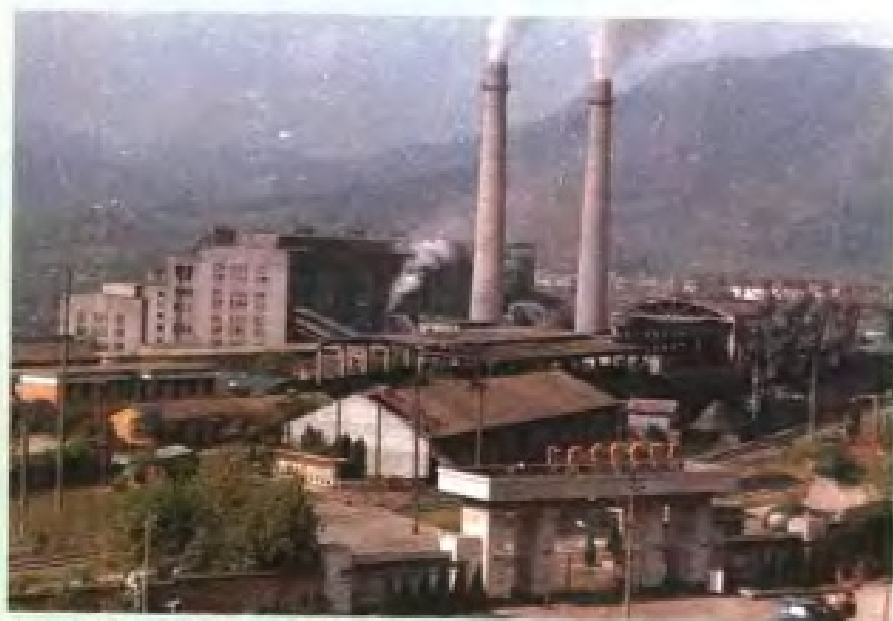
分宜火力发电厂现装机22万千瓦,1969年10月第一台机组投产
