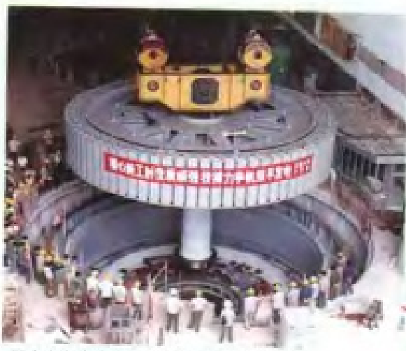
万安水电站的1号机组转子正在吊装就位
