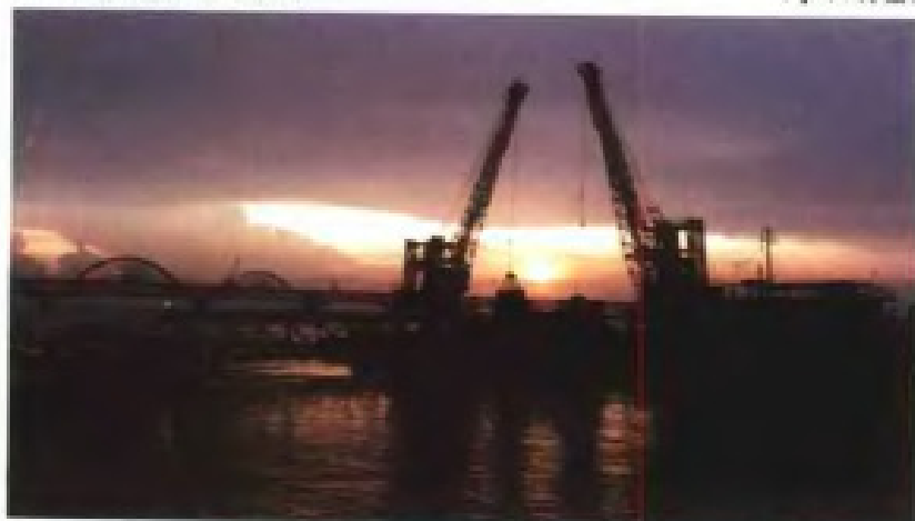
九江火力发电厂卸煤码头
