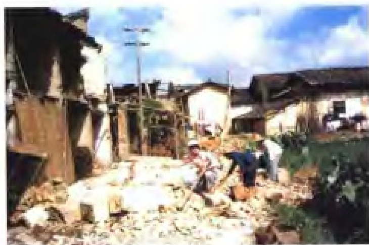
1987年8月2日寻乌5.5级地震时，被震坏的村民房屋。
