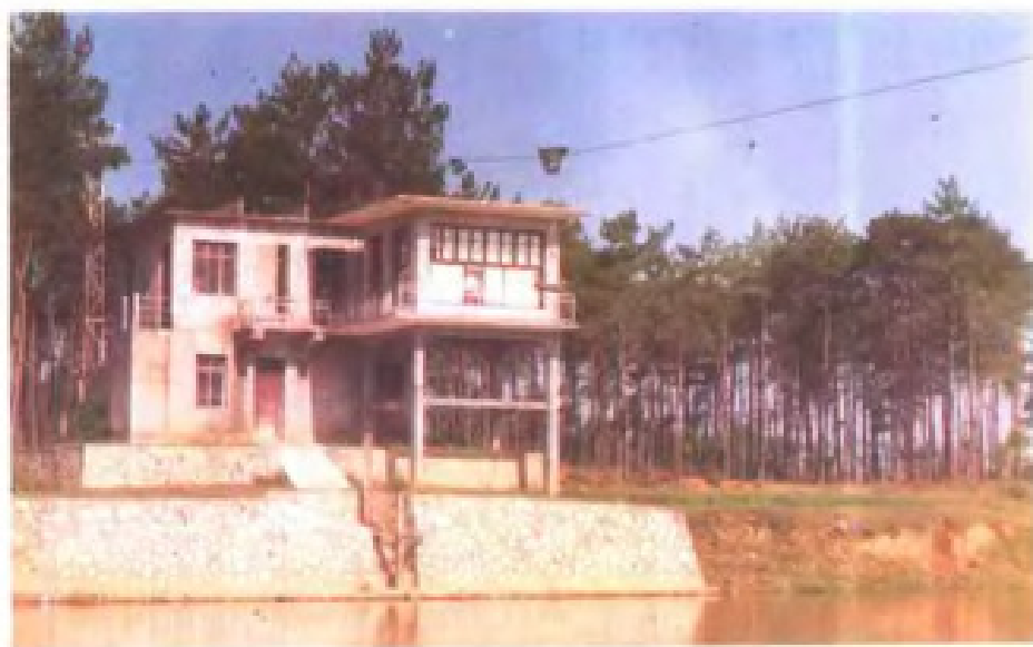
右为水文站的水文缆道操 作室
