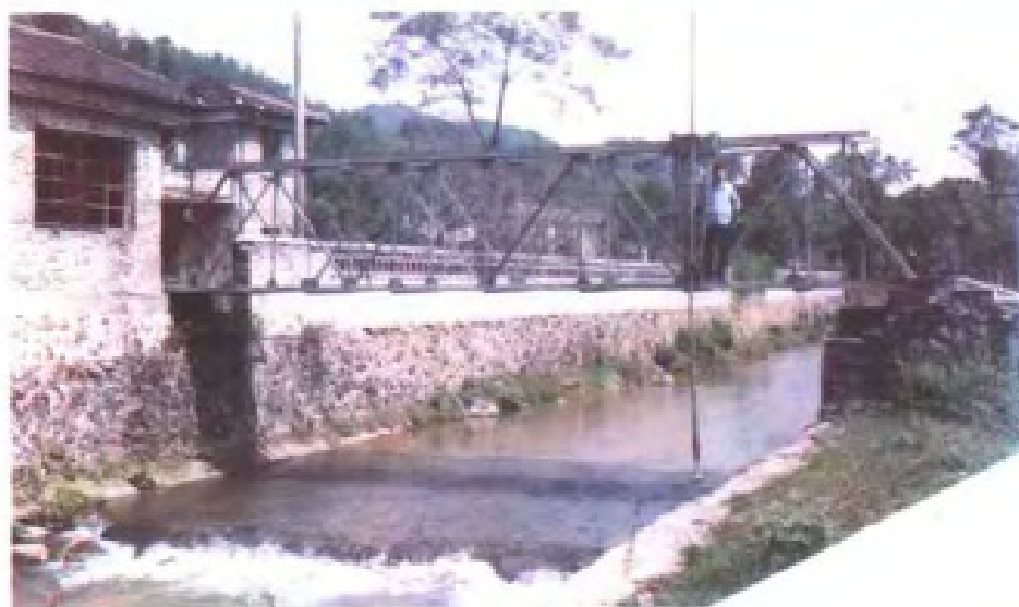
左为水文站的钢桁架测 桥
