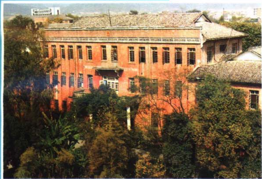
县人民政府办公楼
