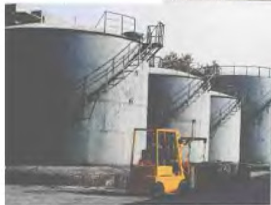
11 徐州市朝阳粮库钢板油罐
