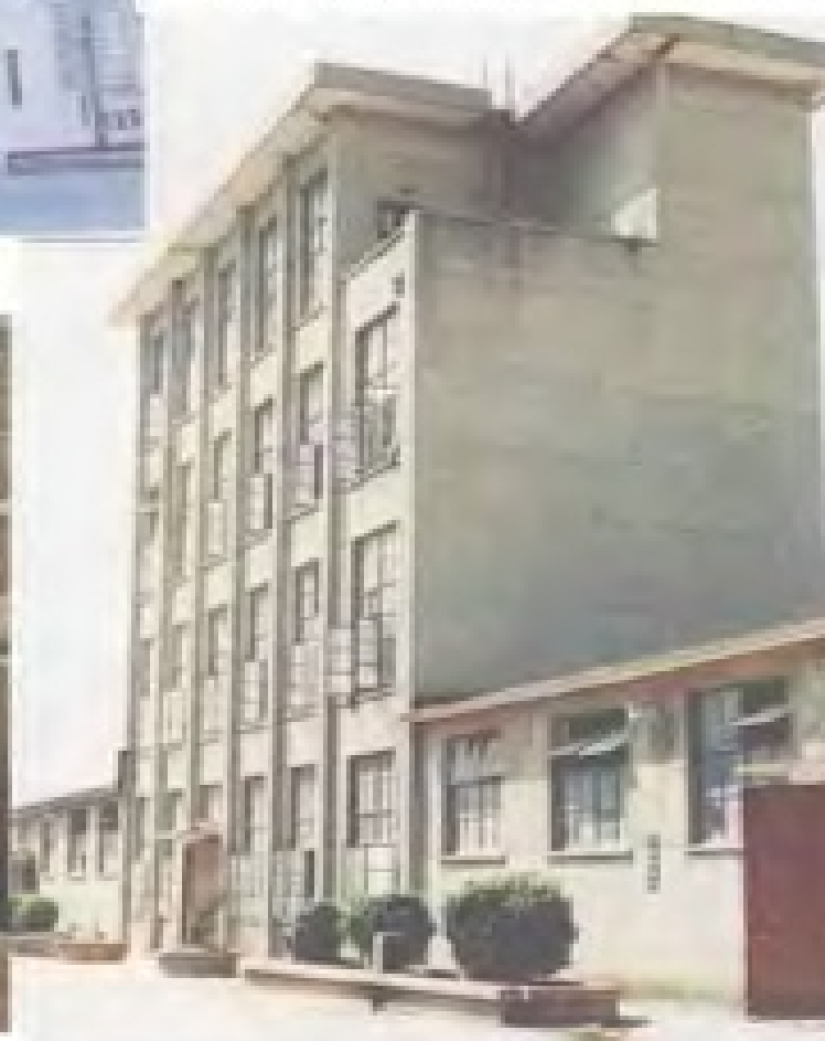
26. 徐州面粉厂配合饲料车间
