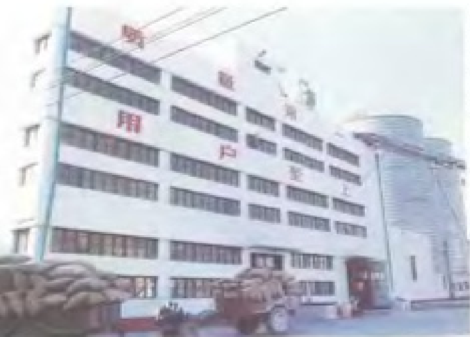
25. 铜山县米厂碾米车间
