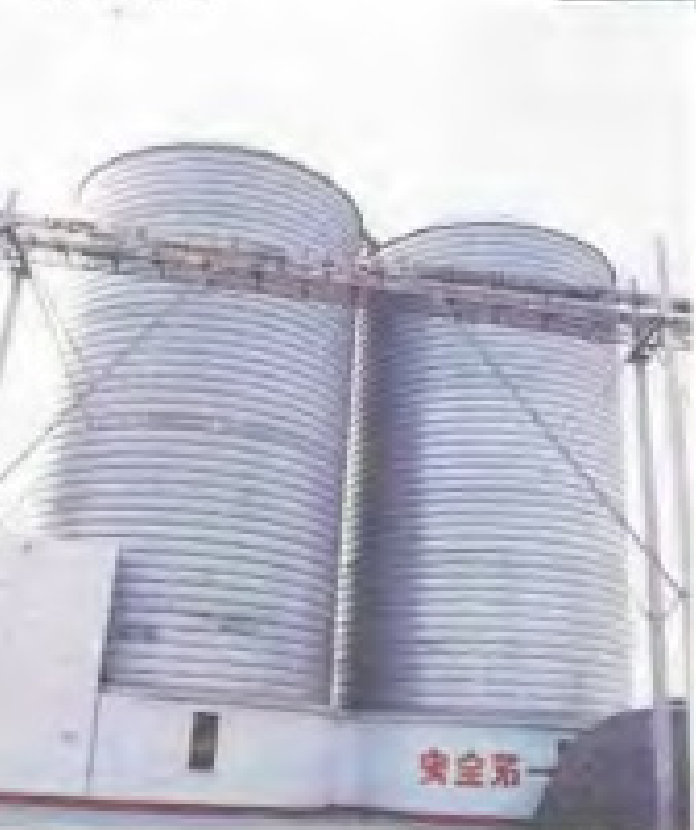
16. 铜山县米厂钢板立筒仓
